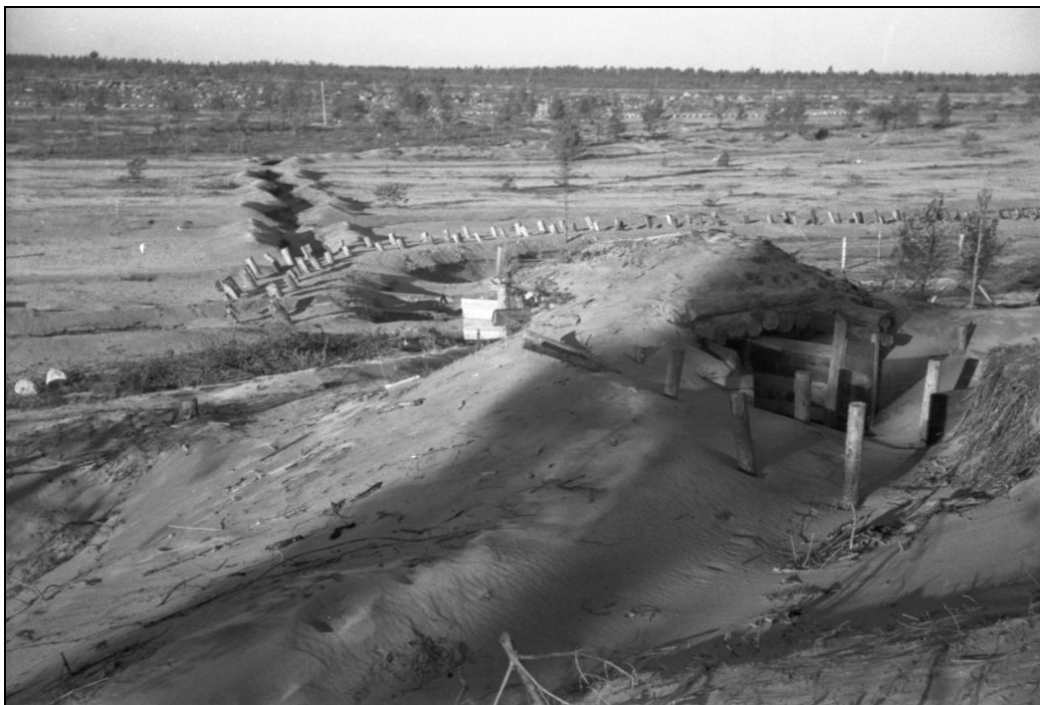
Kuva 3 Konekivääriasema nähtynä takaapäin. Aseman edessä on kaivantoste, jonka edessä on lisäksi panssarivaunuja varten tehty vinopaaluste. Tukikohtaan johtaa etumaastosta mutkittileva yhdyshauta. Kuvan yläosassa erottuu heikosti myöskin kiviesterivi. Kuva: A. Öhrnberg, lokakuu 1942. Nro 114595. SA-kuva.
