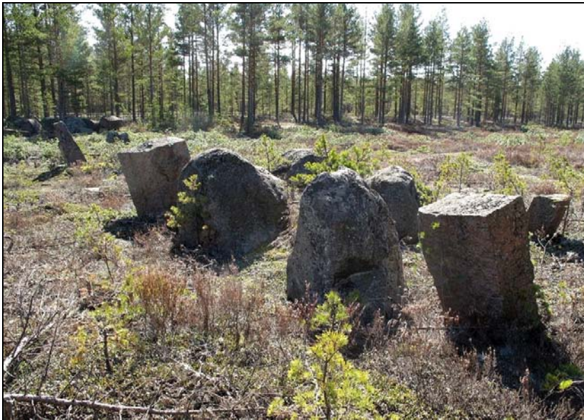
Kuva 18 Panssariesteen Koverhar 7 estekivet ovat Hangon radan pohjoispuolella pienikokoisempia kuin radan eteläpuolella. Luonnonkivien lisäksi on esteessä käytetty muualta tuotuja, muotoon veistettyjä graniittilohkkareita. Kuva: John Lagerstedt, 2009.
