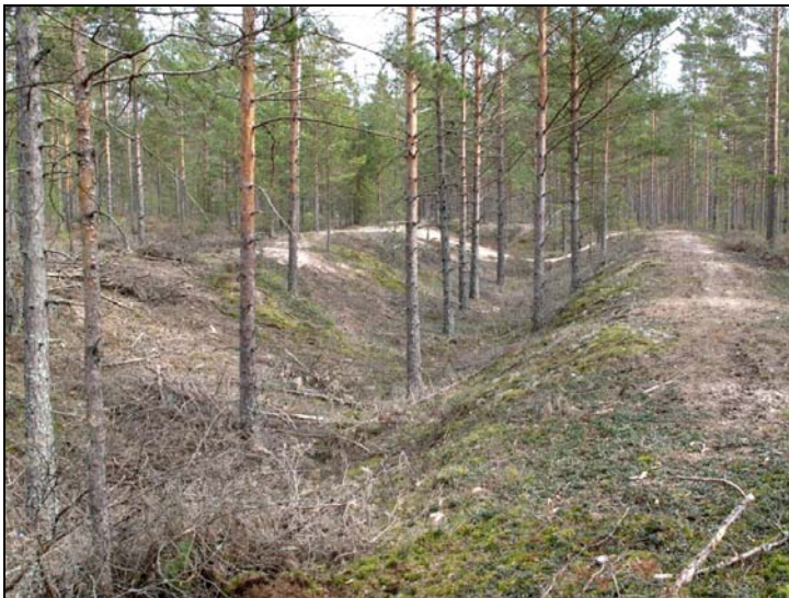
Kuva 17 Suoraviivainen, puolustusasemien edessä sijaitseva kaivantoeste kohteessa Koverhar 6. Kuva: John Lagerstedt, 2009.
