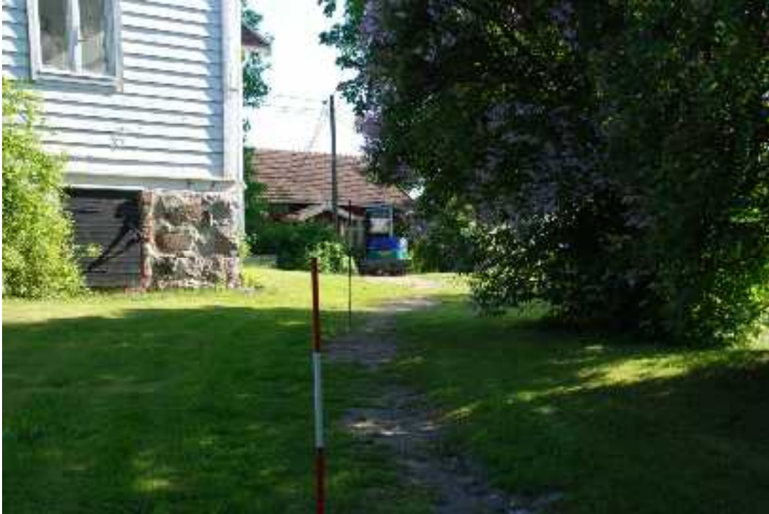
Kuva 3. Sjalö (Sjalö/Fogdeby). Kylätontin pihapiiriä ennen kaivuutöiden aloittamista. Pohjoiskoillisen-etelälounaansuuntainen putkikaivanto avattiin kuvassa näkyvälle linjaseipäin merkitylle linjalle. Kuvattu etelälounaasta. Foto: Juhana Ahlamo / TYA 15:15.
