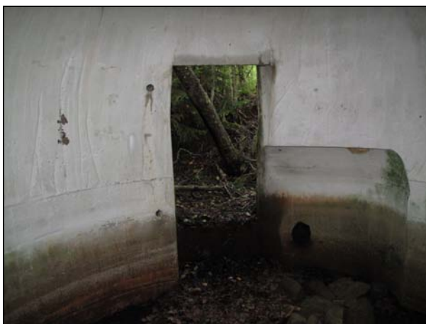
Kuva 13 Herttuansuon pallokorsu nro 1875. Oviaukon oikealla puolella on syvennys kamiinaa varten. Kuva: John Lagerstedt, 2009.
