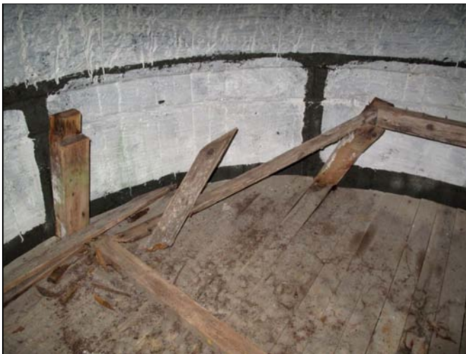
Kuva 9 Pallokorsun 1416 makuulavojen jäännökset ovat vielä jäljellä. Makuulavojen paikat näkyvät valkaisemattomina alueina korsun sisäseinässä. Kuva: John Lagerstedt, 2009.
