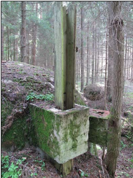
Kuva 12 Korsun 1065A raitisilmakanavan puuhormi on vielä paikallaan. Hormin takana, oikealla näkyy kamiinan savukanavan tukibetoni. Kuva: John Lagerstedt, 2009.
