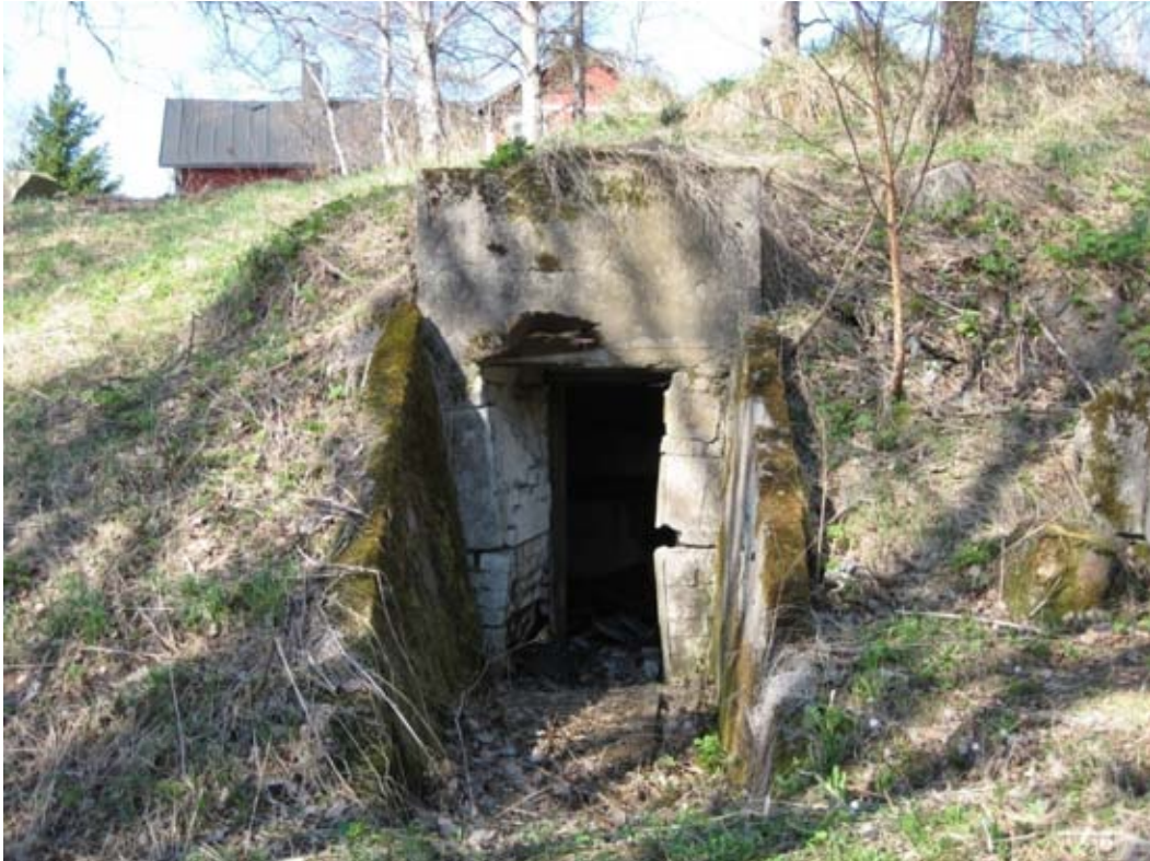
126353:7. Ruukkialueella sijaitseva varastorakenne. E-W. Kuva Katja Vuoristo.
