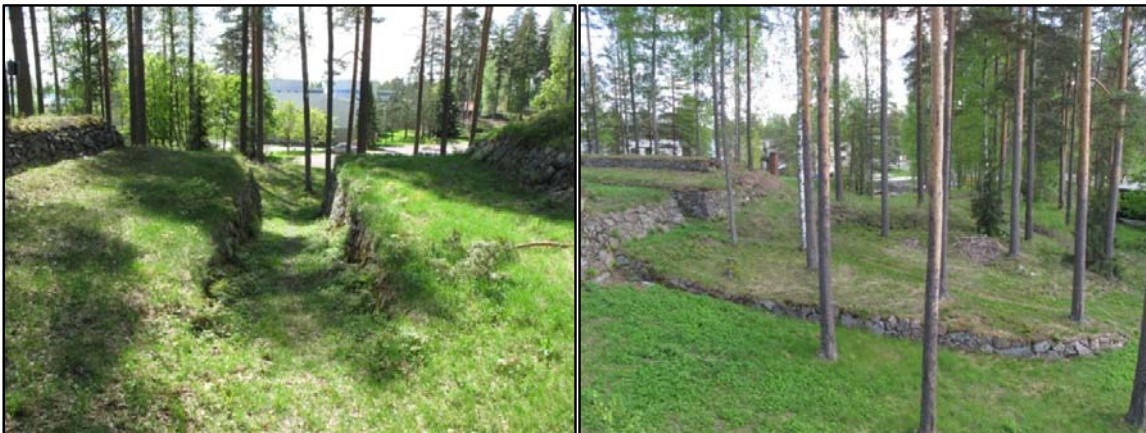
Kuva 34 (vasemmalla) Ensimmäisen bastionin oikean siiven kohdalla alhaalta ampuma-asemilta ylös katvetielle johtava kulkuluiska. Kuva: U. Kõngäs 2009.
