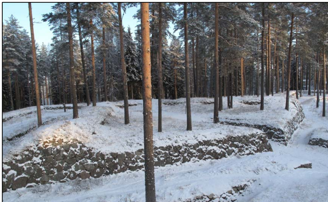
Kuva 20 Raveliini sitadellin pohjoispuolella. Rintamuurin edustalla erottuu ampuma-asetia erottavat matalat maavallit. Kuva: U. Kōngäs 2009.
