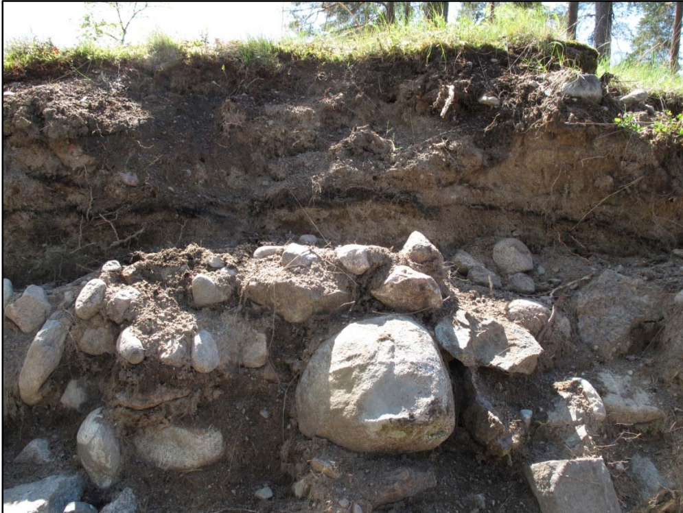
Kuva 30 Korjauksen alla olevan rintamuurin maavallin ja kivitäytteen välissä erottuu eristerakos tummana juovana. Kuva: U. Kõngäs 2009.
