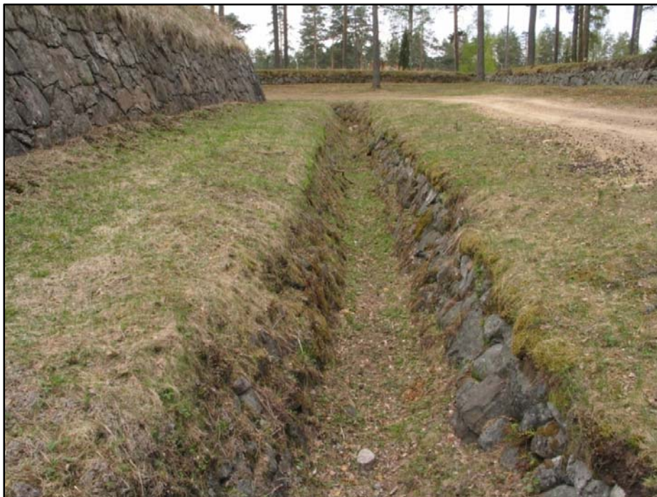
Kuva 22 Kuvassa vasemmalla on sitadellin 3.puolibastionin eskarppimuuri, kuvan keskellä vallihaudan oja ja takana oikealla erottuu uloin rintamuuri. Kuva: U. Köngäs 2009.
