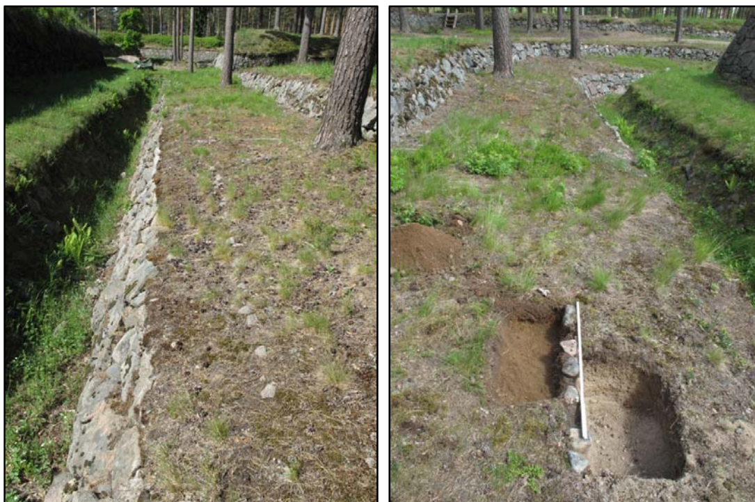
Kuvat 18 - 19 Ensimmäisen puolibastionin vasemman siiven edustalla vallihaudan ojan ja kontreskarppimuurin välissä kulkeva kivirivi ja sen viereen kaivettu koekuoppa. Kuvat: U. Kögäs 2009.
