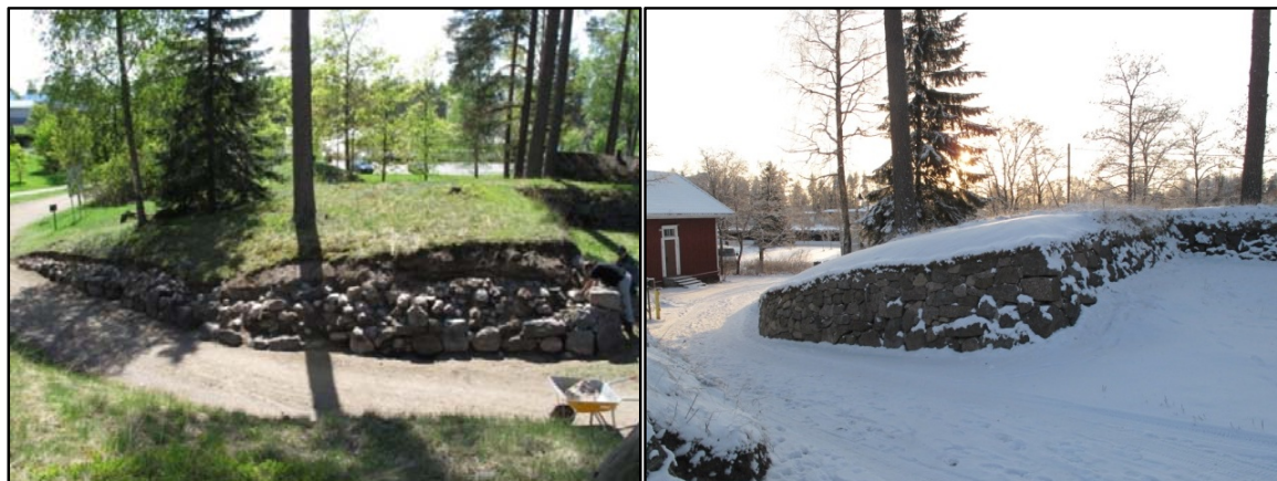
Kuvat 28 Museovirasto kunnostamassa sitadellin kaakkoista sisäänkäyntiä. Kuva: U. Kõngäs 2009.
