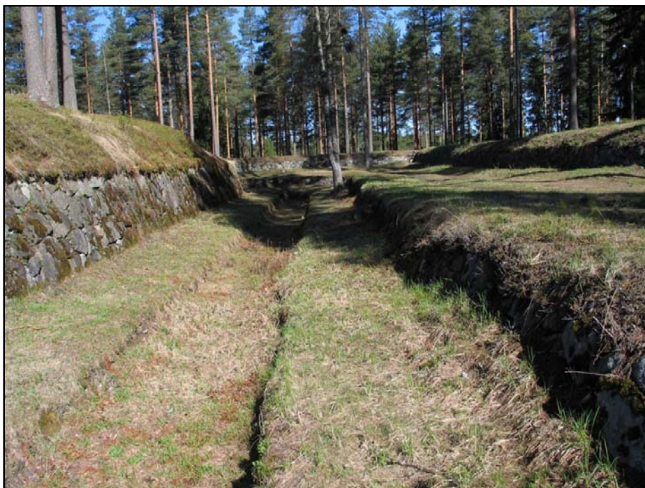
Kuva 21 Ulkovarustuksia raveliin edustalla. Varustukset kuvassa vasemmalta oikealle ovat eskarppimuuri, vallihaudan oja, kontreskarpimuuri ja uloin rintamuuri. Kuva: U. Köngäs 2009.
