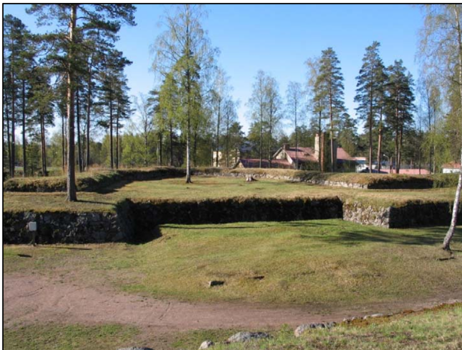
Kuva 13 Sitadellin bastioni. Bastionin edessä erottuu sitadellin vahtituvan pohja neliskanttisena kumpareena. Kuva: U. Köngäs 2009.
