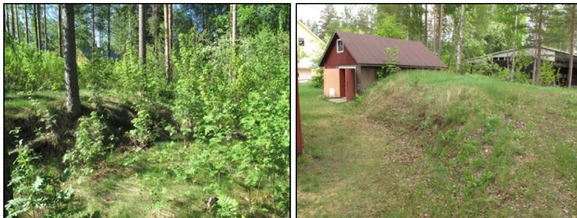
Kuva 73 (vasemmalla) Rintamuuria itäisillä ulkovarustuksilla raveliin eteläpuolella. Kuva: U. Köngäs 2009.
