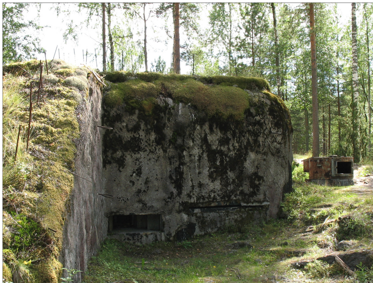
Kuva 2 Kestolinnoitettu betoninen konekiväärikorso ja panssarivaunun tornista tehty teräspesäke Luumäen Askolassa. Kuva: John Lagerstedt 2008.
