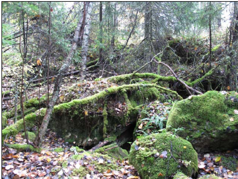
Kuva 12 Suojahuoneen I:18.25 katto on räjäytetty ja kasvillisuus on vallannut rakenteet. Keskellä erottuu vielä yksi kattoa tukenut teräspalkki. Kuva: John Lagerstedt.
