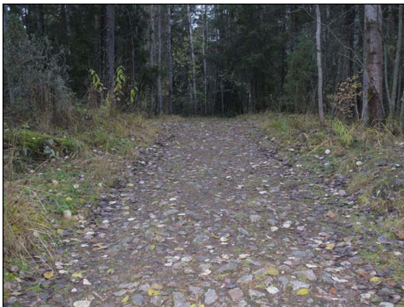
Kuva 10 Kivillä ja makadamilla päällystetty yhdystie eli nk. tykkitie Mustavuoren eteläosassa. Kuva: John Lagerstedt, 2009.
