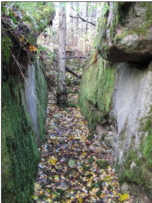
Kuva 13 Betonilla tuettua yhdyshautaa kohteessa I:19. Kuva: John Lagerstedt, 2009.
