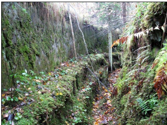
Kuva 4 Betonilla tuettu taisteluhauta kohteessa I:19. Kuva: John Lagerstedt, 2009.
