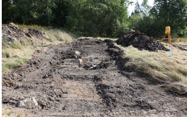
Kuva 3. Alue 2A pintaturpeen poiston jälkeen. Kuvan etualalla on näkyvissä soratäytteinen salaojaputkikaivanto ja sen takana suuria luonnonkiviä. Kuva on otettu itään. R. Väisänen
