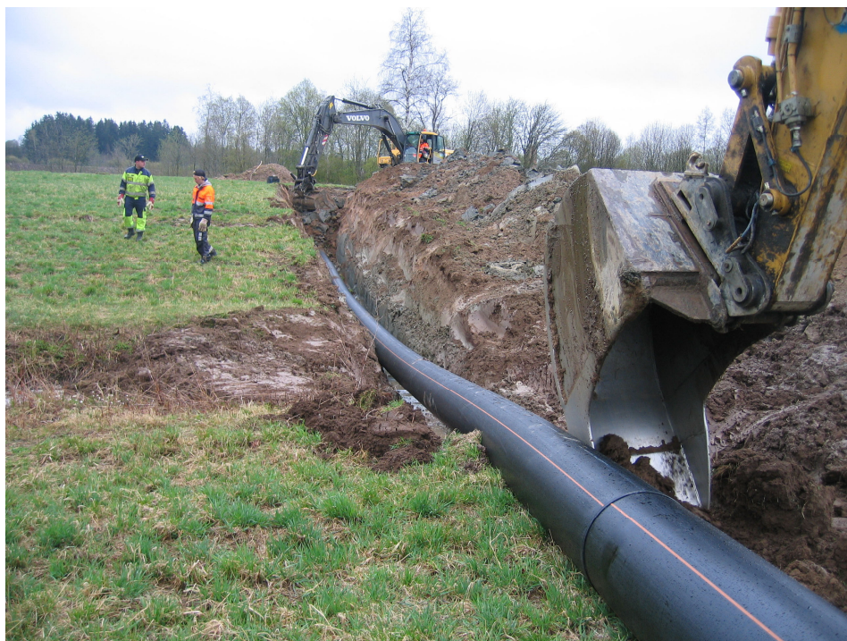
Kuva 2. Kaivinkone työntää kauhallaan viemäriputken kuoppaan. Länestä. Tiina Jäkärä. 6.5.2009.
