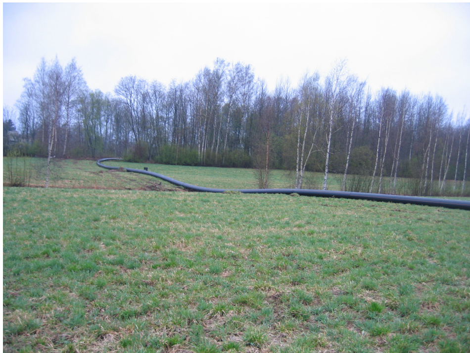
Kuva 1. Maahan laskettavaa viemäriputkea Saaren pellolla. Idästä. Tiina Jäkärä. 6.5.2009.
