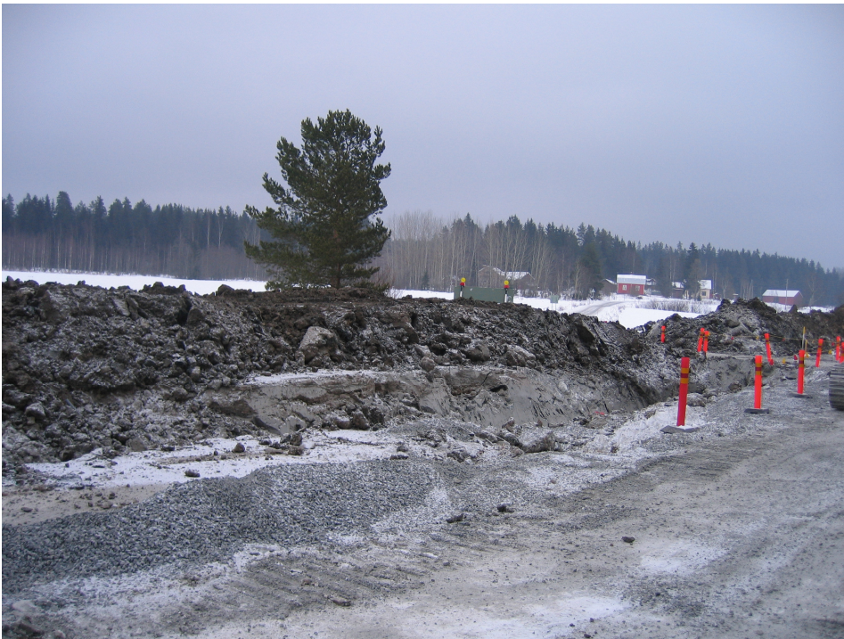
3. Itkontie. Tien katkaisukohta erottuu savimaana kuvan keskellä. Länestä. Tiina Jäkärä. 24.2. 2009.
