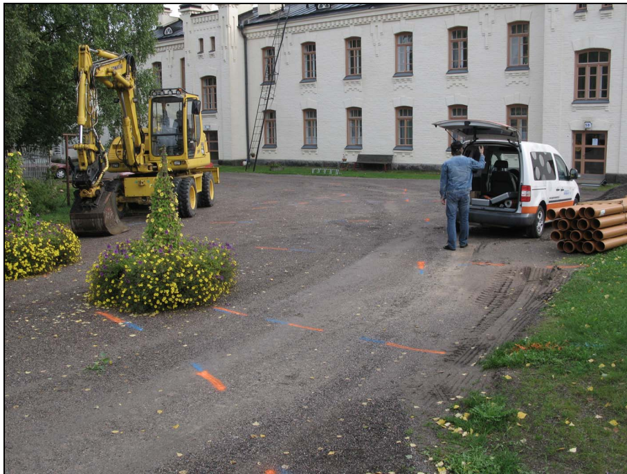
Kuva 5. Kirkon ja rakennusten 2 ja 4 välinen alue kaapelinäytön jälkeen. Lännestä. Kuva: W. Perttola/Museovirasto.
