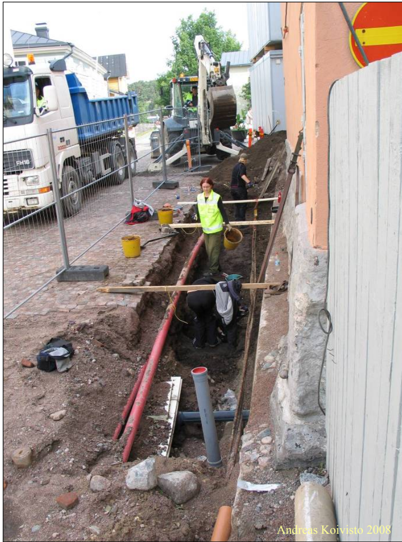
Kuva 1. Oja 1 Jokikadulla, Raatihuoneen lounaisseinän vieressä.
