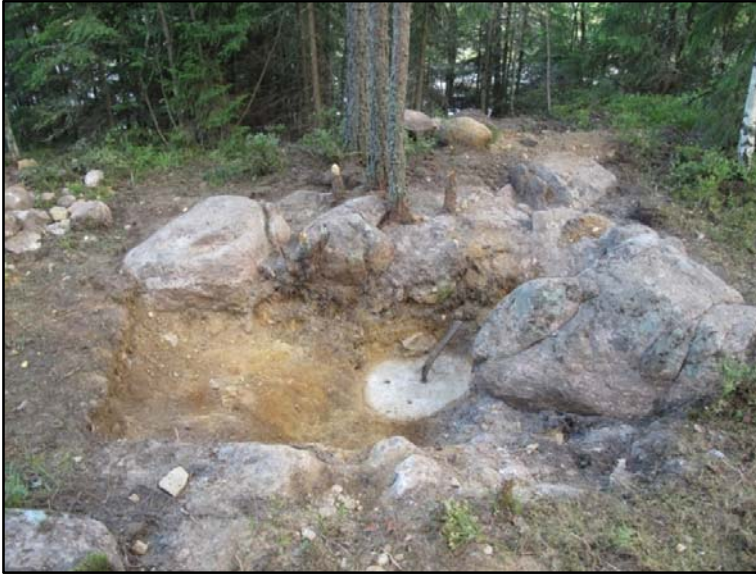
Kuva 20 Kaivausalue 3 kaivettuna pohjaan. Kuvan keskellä näkyy kallioon poratut tukiraudan paikat ja yksi paikoillaan oleva tukirauta. Kuva: U. Köngäs 2009.
