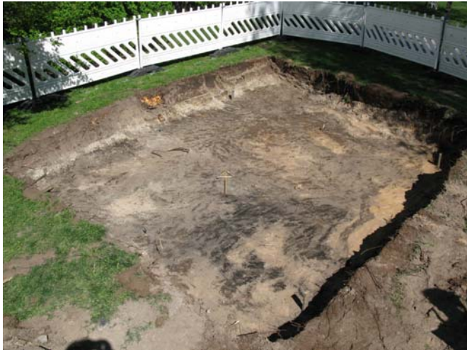
Kuva 126050:2. Kaivausalue, kaivauksen aloitustaso. MV/RHO.
