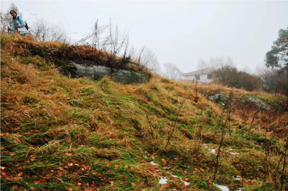
Bystolas. Bunkkerin betoniseinää kuvattuna lännestä. (DG850_1)
