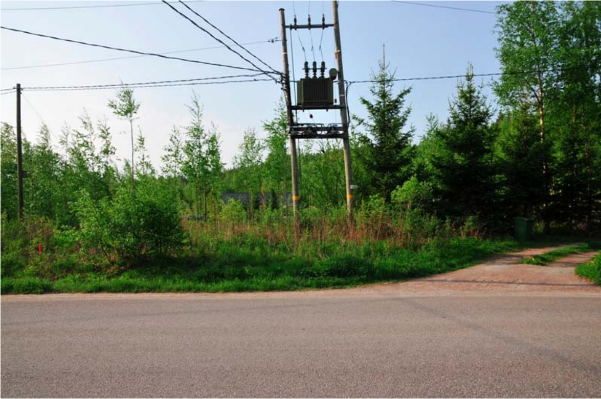
Kopun torppa. Kivikautinen irtolöytöpaikka kuvattuna pohjoisesta. (DG838_1)
