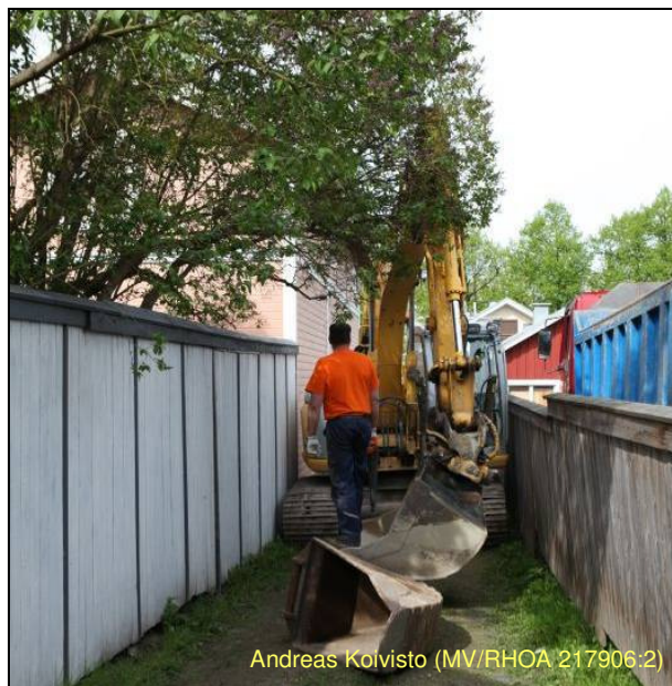
Kuva 1. Kaivinkoneella oli vaikeuksia mahtua ahtaalle kujalle. Koneen tieltä piti sahata naapuritonttien puiden oksia sekä poistaa aitoja.
