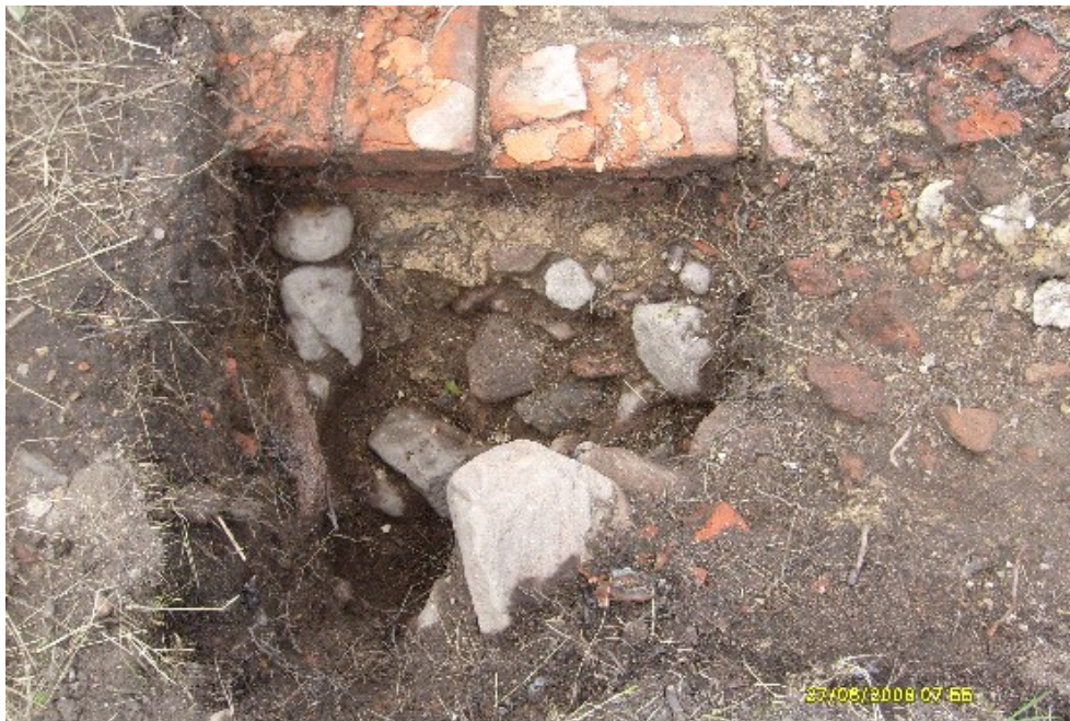
Kuva 30: Koekuoppa 1 pohjaan kaivettuna. Kuvassa näkyy selvästi rintamuurin alla oleva laastikerros sekä kuopasta paljastunut täyttökivikerros. NW. Kuva: KyM/M. Kykyri.
