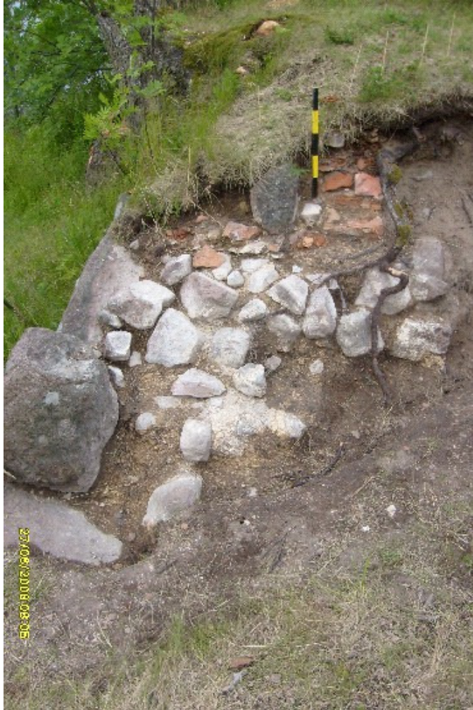
Kuva 29: Vasemman kyljen eskarppimuurin alaosa oli kivistä ja yläosa tiilestä muurattu. Mittatikun vasemmalla puolella näkyvä iso kivi on sen molemmin puolin sijaitsevan tiilikuoren välistä kivitäyttöä. NE. Kuva: KyM/M. Kykyri.
