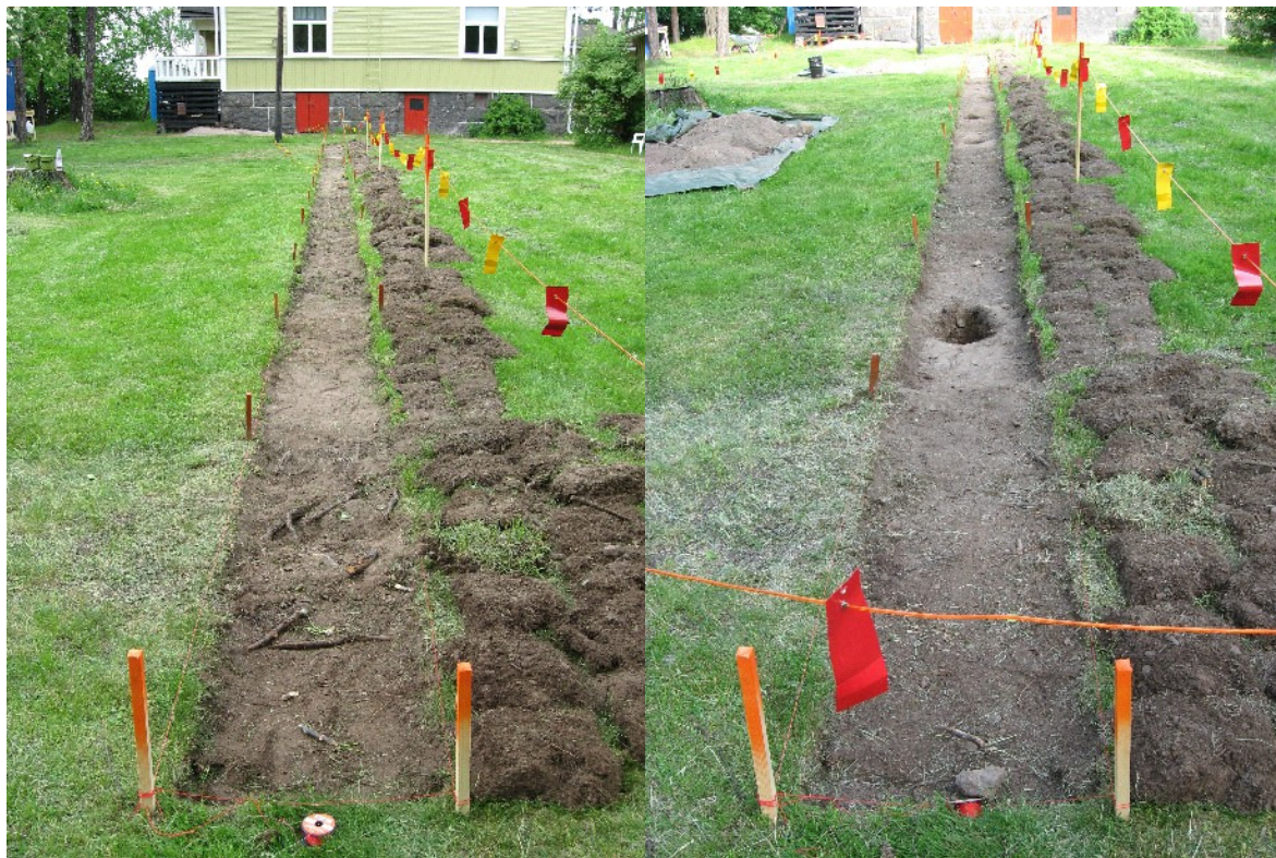
Kuvat 10-11: Vasemmalla koeoja 2 turpeen poiston jälkeen ja oikealla pohjaan kaivettuna. SE. Kuvat KyM/M. Kykyri.
