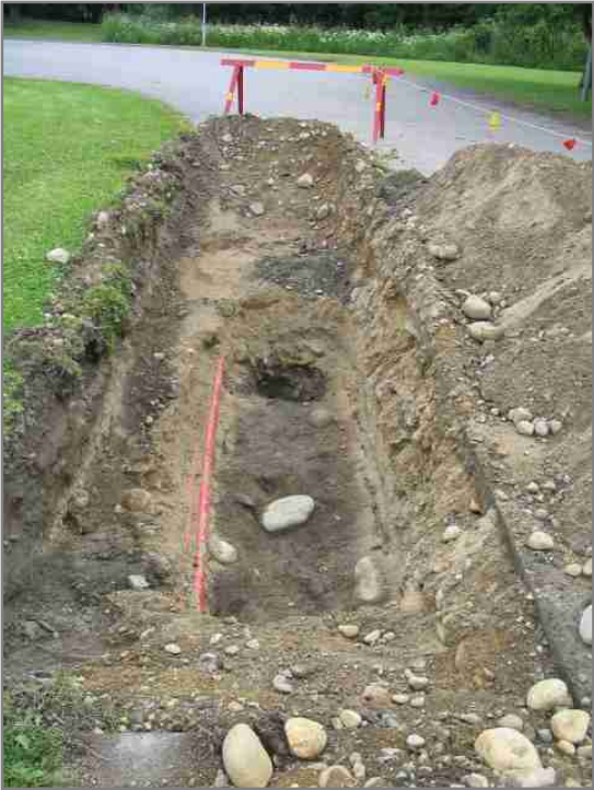
DG670:7. Sairaalan alapihan koillisempi koeoja. Puhelinkaapelilinja kulkee punaisen putken kohdalla. Alempana näkyvä tumma kerros on ilmeisesti sairaalan rakentamisen aikaista tiekerrosta. Etelälounaasta. Kuva Katja Vuoristo.
