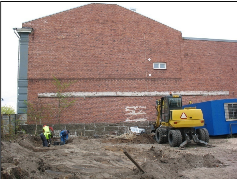
Dig.kuva 217885:1. Pintamaan poistoa kaivinkoneella. NW-SE. Kuva Katja Vuoristo.
