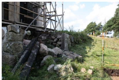
DG1134:35 ja 36. Työkuvia. Kuvat
