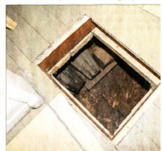
Haukiputaan kirkon remontissa parannetaan myös lattia tuuletusta. Lattian alla olevien arkkujen ympäriä on poi puusäleitä.
