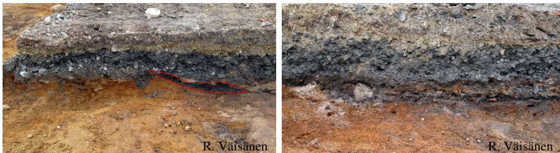
Kuvat 20 ja 21. Koeoja 4:n eteläprofiilia. Vasemmalla profiilin itäreuna, jossa sepelikerroksen alla suoraan pohjahiekka, sekä punaisella merkitty hiiltynyt puu. Oikealla profiilia keskemmältä koeojaa, jossa sepelikerroksen alla on havaittavissa ohuehko sekoittunut kerros. Kuvat otettu lounaaseen.
