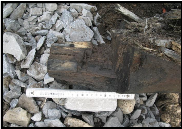
DR13, koillis-lounaisseinän alin hirsi ja salvo. Kuvaaja M. Hyttinen. Liite 10, kuva 27.
