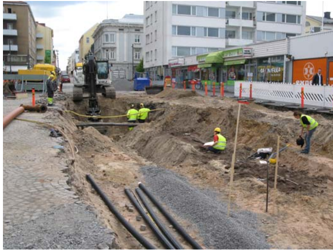
Kuva 8. Vesijohtokaivanto keskellä Pakkahuoneenkatua. Digikuva 126343:16.
