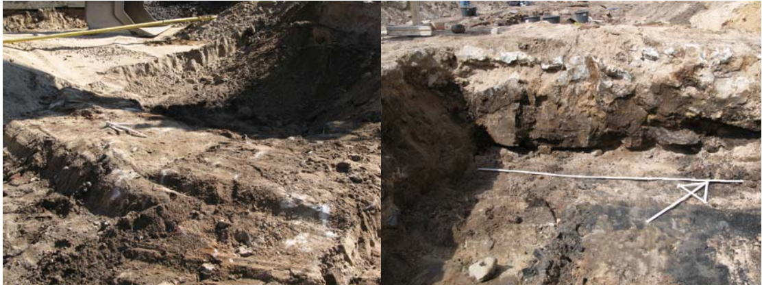
Kuvat 66 ja 67. Vasemmalla betonoitu kivijalka DR4 pinnalta. Oikealla DR4 sisäpuolelta, alla kivet, päällä betonia. Keskellä näkyy mustaa puuroskamaata DSY5. Digikuvat 126343: 120 ja 121.
