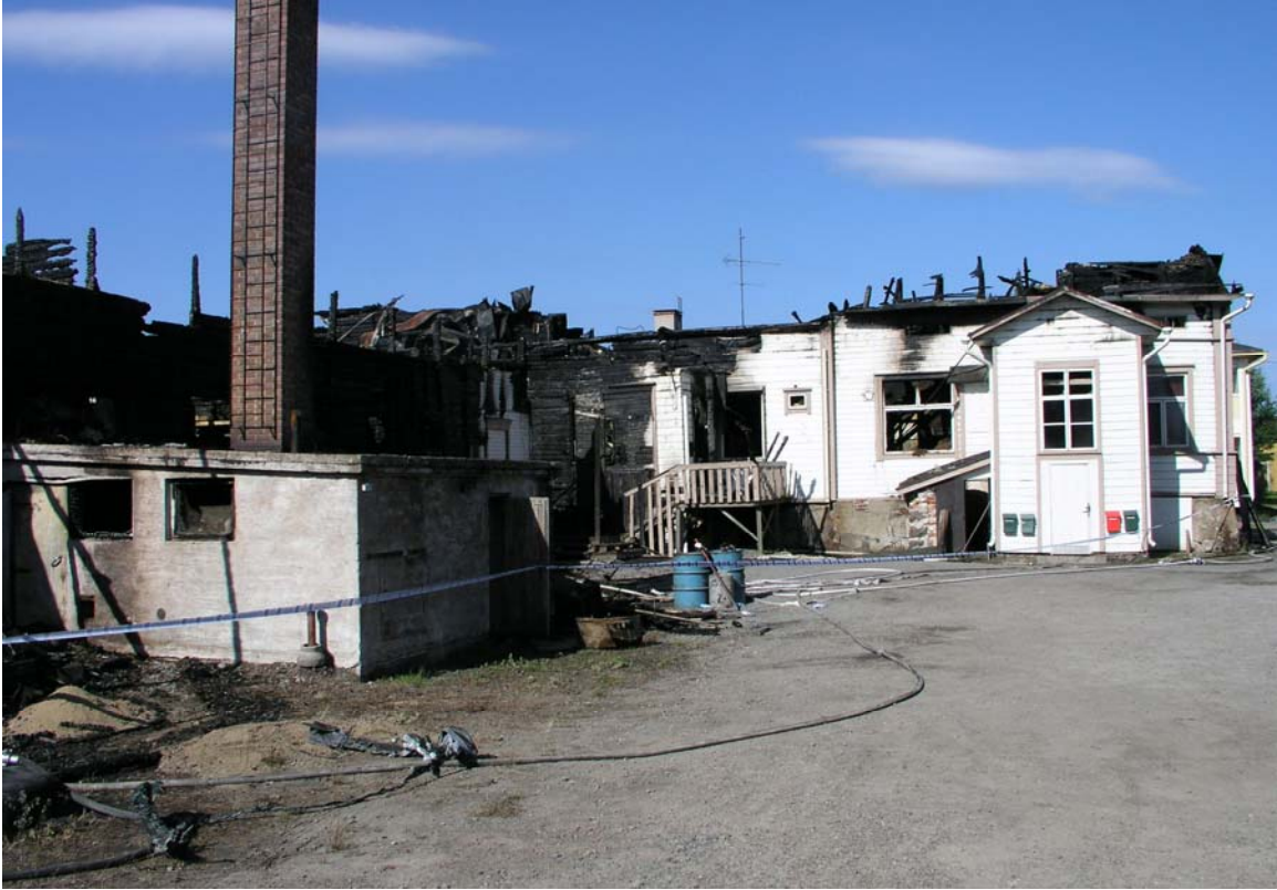
Kuva 6. Sisäpiha elokuussa 2005. Oikealla näkyvän kuistin vasemmalla sivulla käynti kellariin. Vasemmalla pannuhuonetilat. (Kuva Raahen museon arkisto/ J. Turunen.)
