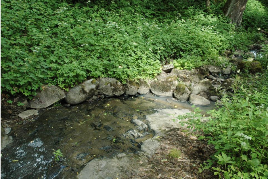
Kuva 1. Puolipatoon liittyviä reunuskiviä ylemmän kaivausalueen tuntumassa. Kuvaussuunta 350°. (DSC_0177.jpg)
