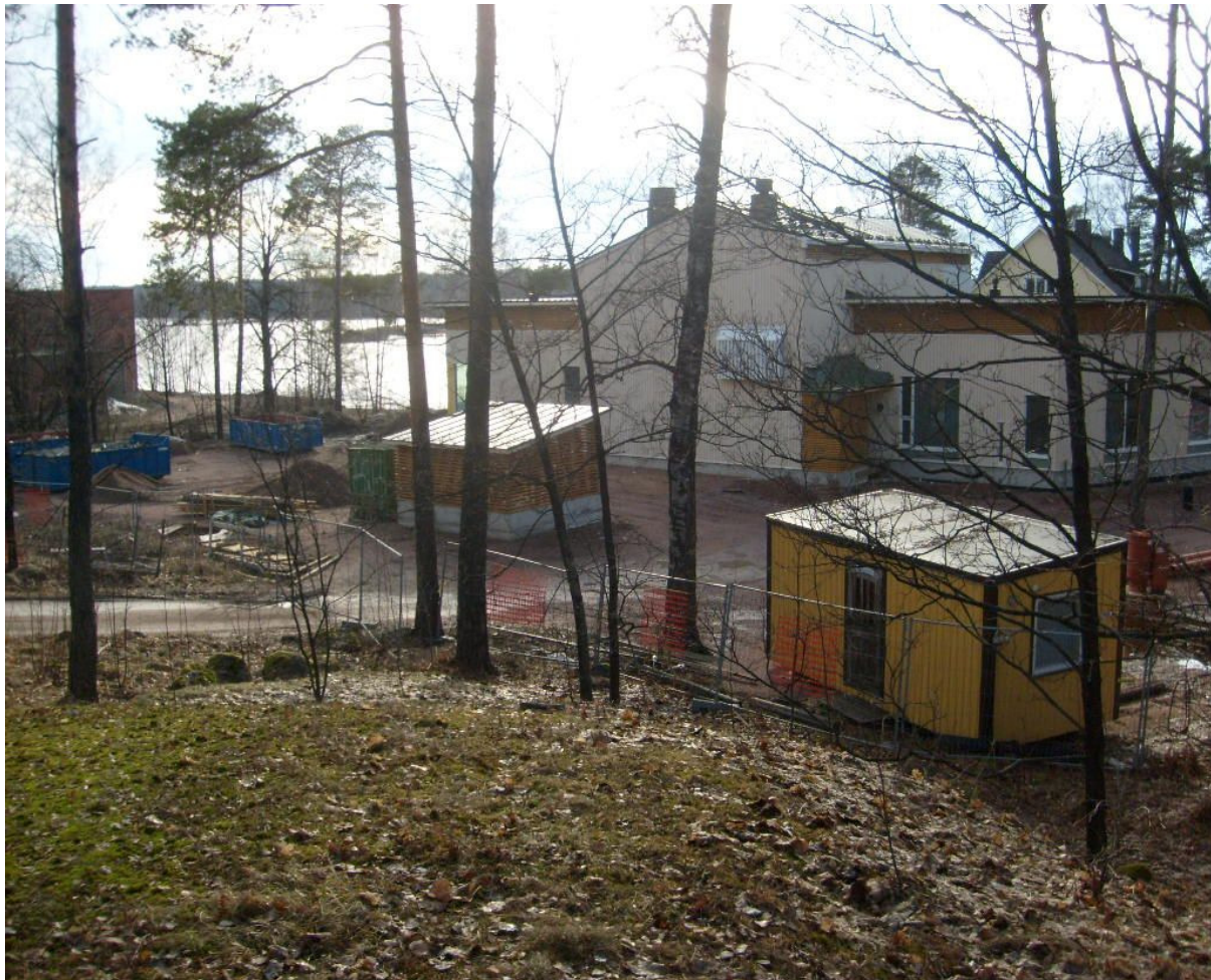
Kuva 16: Haukkavuoren päiväkodin aluetta huhtikuussa 2010. Uuden päiväkodin takana pilkistää Meripirtin päiväkodin harjakatto. Vuotta aiemmin alueella dokumentoitu kiviperustus sijaitsi kuvan etualalla näkyvän aitalinjan ja vasemmanpuoleisen sinisen siirtolavan välimaastossa (E). Kuva KyM/M. Kykyri
