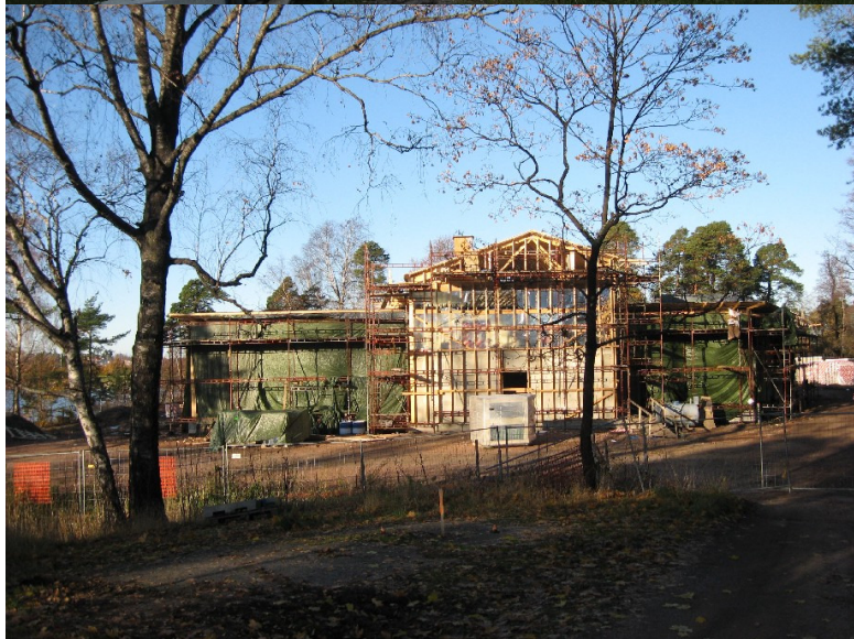
Kuvat 2-4: Meripirtin päiväkodin aluetta suunnasta SE. Ylinnä keväällä 2008 ennen alueella sijainneen Haukkavuorikodin ja saunarakennuksen purkamista, keskellä kesällä 2009 sekä alhaalla syksyllä 2009 kun Haukkavuoren uusi päiväkoti oli saavuttanut harjakorkeutensa. Dokumentoitu rakennuksen perustus sijaitsi ylimmän kuvan keskivaiheilla poikittain tien nähden. Kuva KyM/M. Kykyri.
