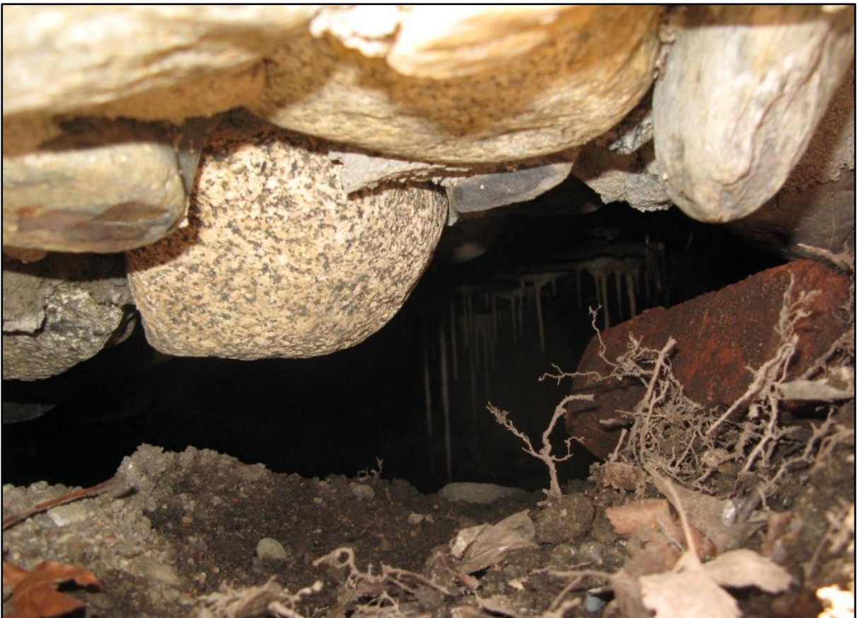
Kuva 3. Rakenne oli täytetty tai täyttynyt lähes kokonaan. Kuva: V.-P. Suhonen 2009.
