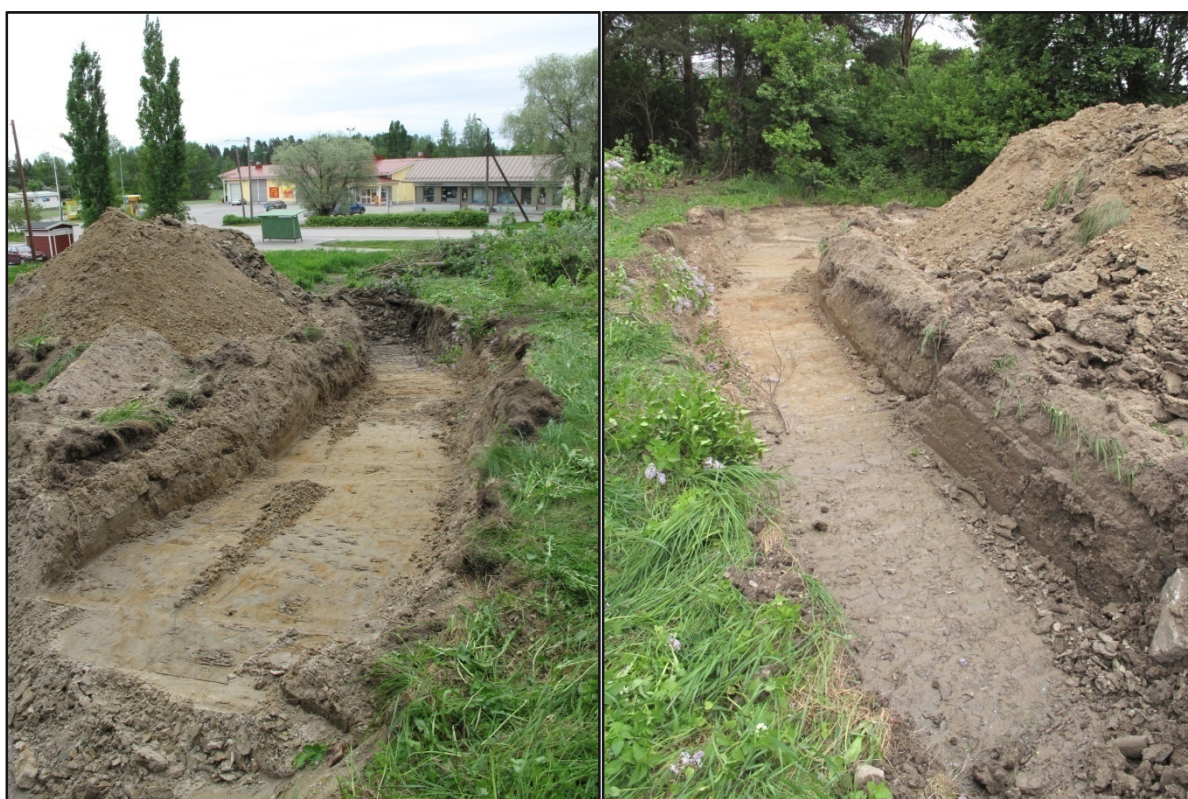
Kuvat 12 - 13 Vasemmalla on koeojan 4 länsipääty ja oikealla itäpääty. Oikealla olevasta kuvasta näkee miten rusehtava silttimaa vaihettuu harmaaksi saveksi alemmaksi tultaessa. Kuvat: U: Köngäs 2010.
