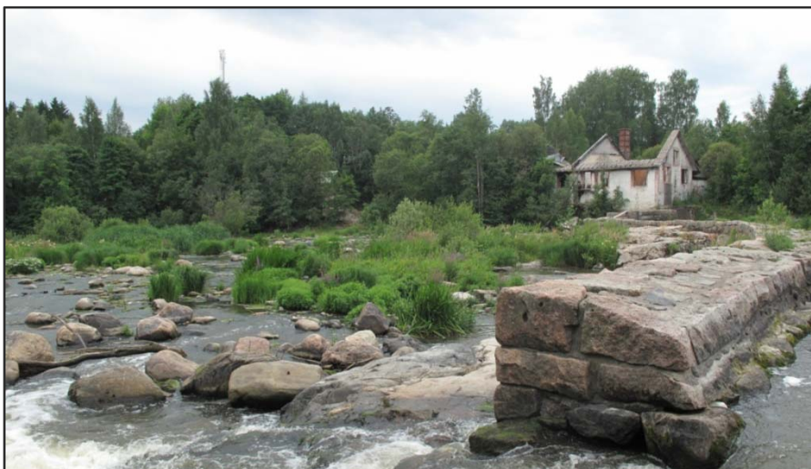
Kuva 1 Yleiskuva Vantaan joesta. Kuvassa näkyy vuonna 1892 rakennettu mylly ja sen pato. Tutkimusalue sijaitsi myllyn vasemmalla puolella. Kuva: U. Köngäs 2010.
