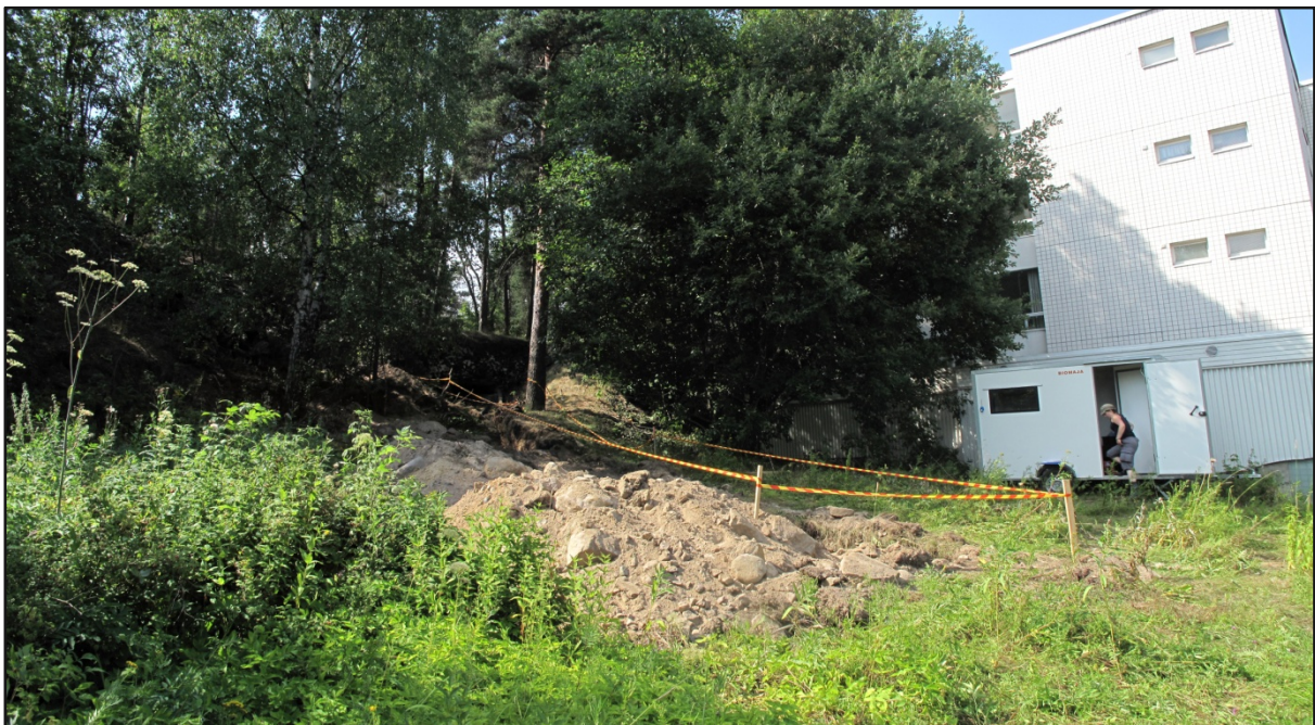
Kuva 1 Yleiskuva tutkimusalueesta. Betoninen rintavarustus sijaitsee puiden lomassa, koeojan päässä. Kuva: U. Köngäs 2010.
