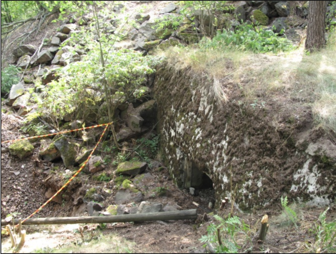
Kuva 3 Betonisen rintavarustuksen edustalla oli runsaasti lohkokiviä. Kuva: U. Köngäs 2010.
