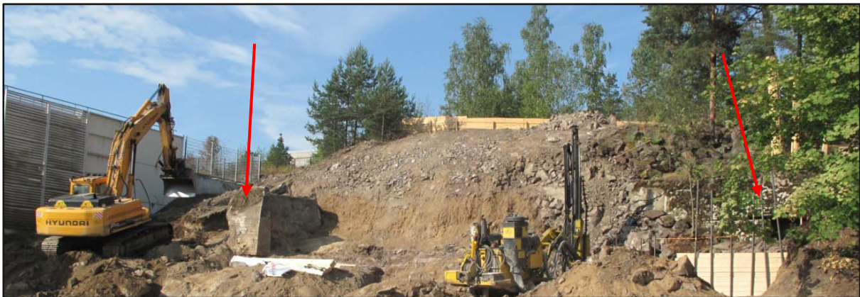
Kuva 7 Näkymä rakennustyömaalle rakennustöiden alettua. Eteläisemmän tykkiaseman betoninen rintavarustus on osoitettu nuolella kuvan vasemmassa laidassa ja keskimäinen tykkiasema kuvan oikeassa laidassa. Kuva: U. Köngäs 2010.
