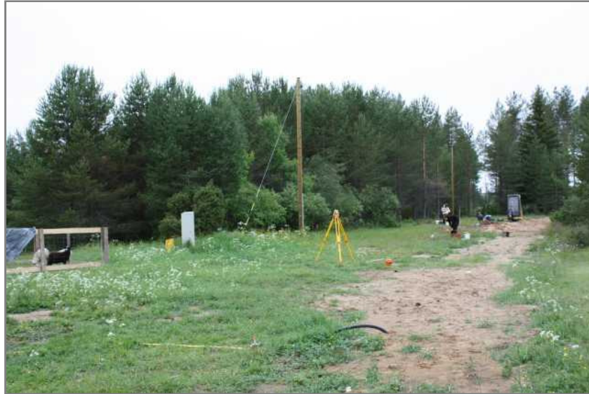
DG1212:5. Vuonna 2009 tehty vesijohtolinja erottuu terassitasanteella hiekkaisena alueena. Taustalla kaivinkoneen edessä jo osittain käännetty lentopallokenttä. Idästä. Kuva Katja Vuoristo.
