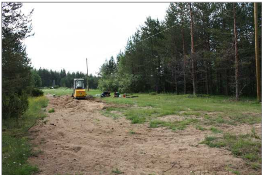
DG1212:4. Vesijohtokaivannon ja suunnitellun lentopallokentän paikka Mattilan tilan luoteisosassa. Luoteesta. Kuva. Katja Vuoristo.
