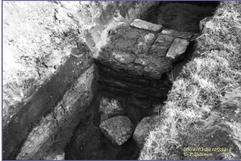
Kuva 3: Tiiliseinä kuvattuna kaakosta.
