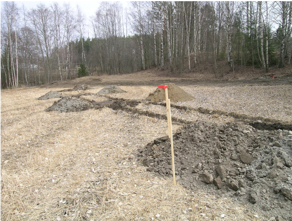
Kuva 3. Yleiskuva kaivantojen D-F alueesta tutkimusten loppuvaiheessa. H-L Salminen/PMM/KYY
