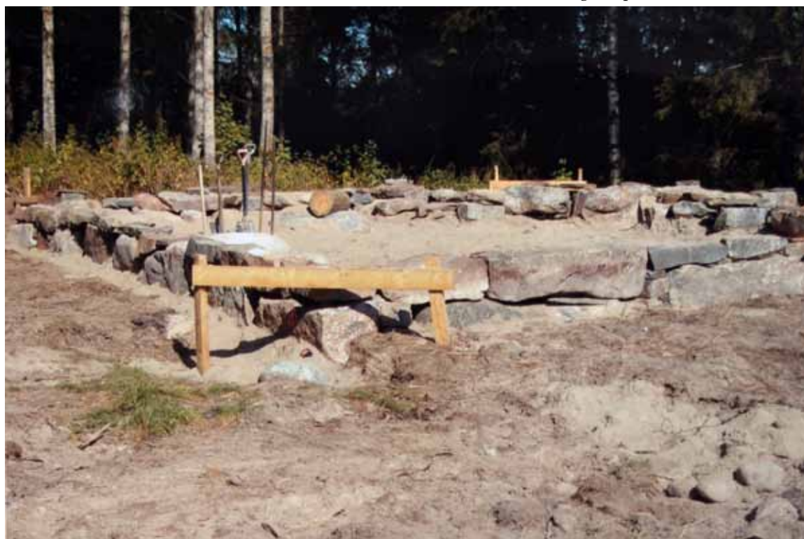
Bild 19. Stenfundament för den kyrkorekonstruktion under uppbyggnad på 2000-talet. Tagits från söder-sydväst. Foto: Kronoby hembygdsförening.
