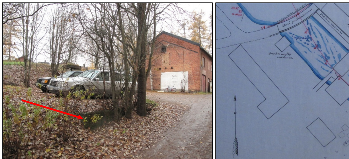
Kuva 29 Hiilivaraston paikka nykyisin. Kuvan etualalla näkyy säilynyt betoniperustuksen osa. Kuva: U. Kögäs 2010.
