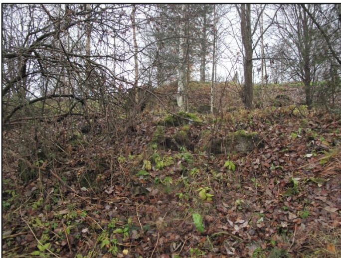
Kuva 28 Mahdollisen sortuneen varastorakennuksen paikalla erottui runsaasti irtonaisia betonilohkareita. Kuva: U. Köngäs 2010.
