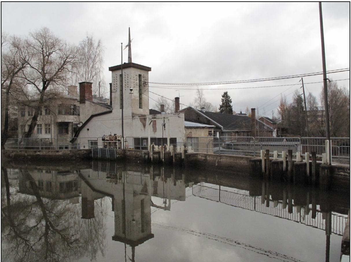
Kuva 1 Patoallas ja itärannan tehdasrakennuksia. Kuva: U. Köngäs 2010.
