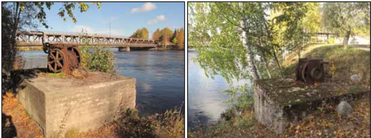
Kuvat 50 - 51 Vasemmalla länsirannan vinssi ja oikealla itärannan vinssi. Kuvat: U. Köngäs 2010.
