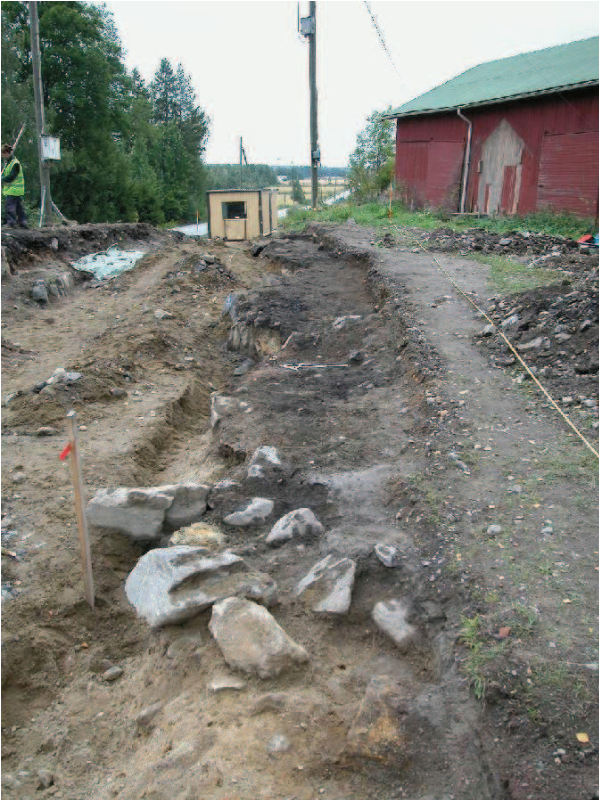
Kuva 2. Alue A, yksikkö Y 301 kaivettu pois. KY 28:3. Kirsi Luoto.
