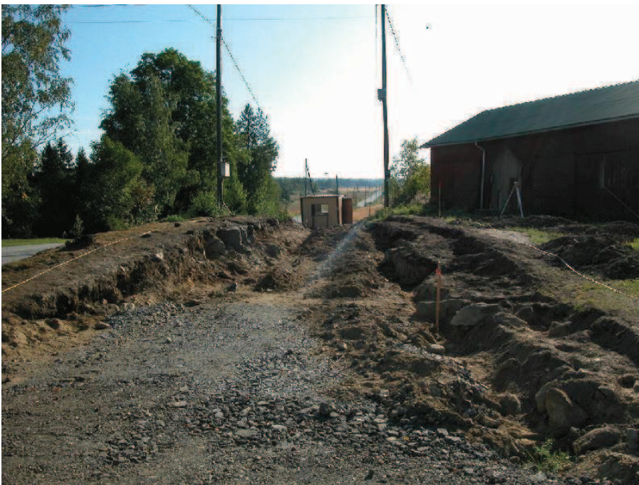
Kuva 1. Yleiskuva, alueet A ja B kaivinkoneen kaivuun jälkeen. KY 28:1. Kirsi Luoto.
