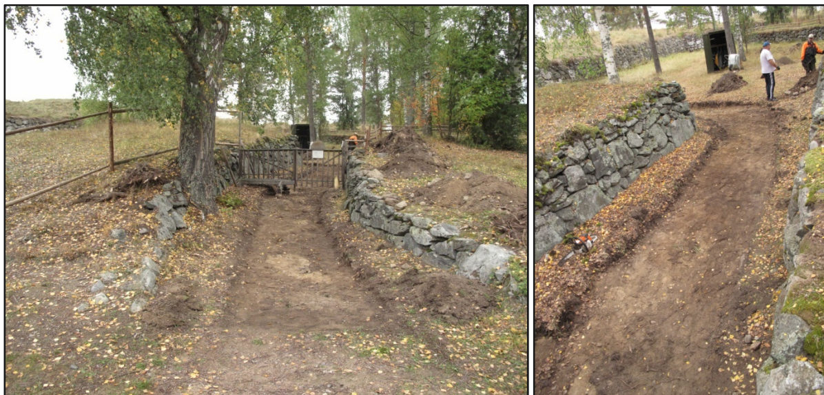
Kuva 9 (vasemmalla) Osan 3 itäpääty. Tielinjaus päättyi itäreunastaan paikoitusalueen reunaan. Kuva: U. Köngäs 2010.
