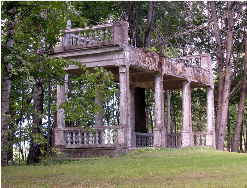
Kuva 2. Vuonna 1942 palaneen kartanon päärakennukseen kuulunut pylväikkö. Ponsantien puoleinen pylväikkö. Kuva: 088.jpg.
