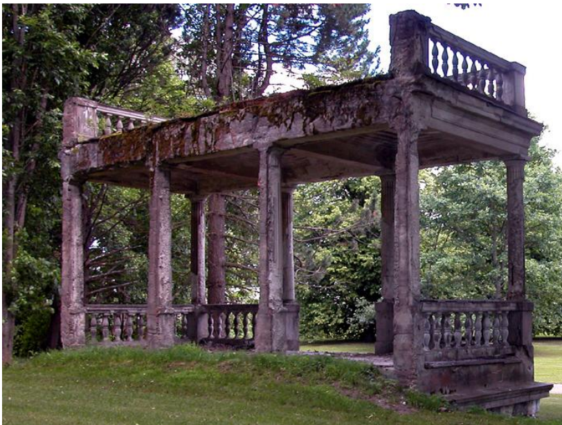
Kuva 3. Vuonna 1942 palaneen kartanon päärakennuksen pylväikkö. Kartanon pihanpuoleinen pylväikkö. Kuva: 090.jpg.
