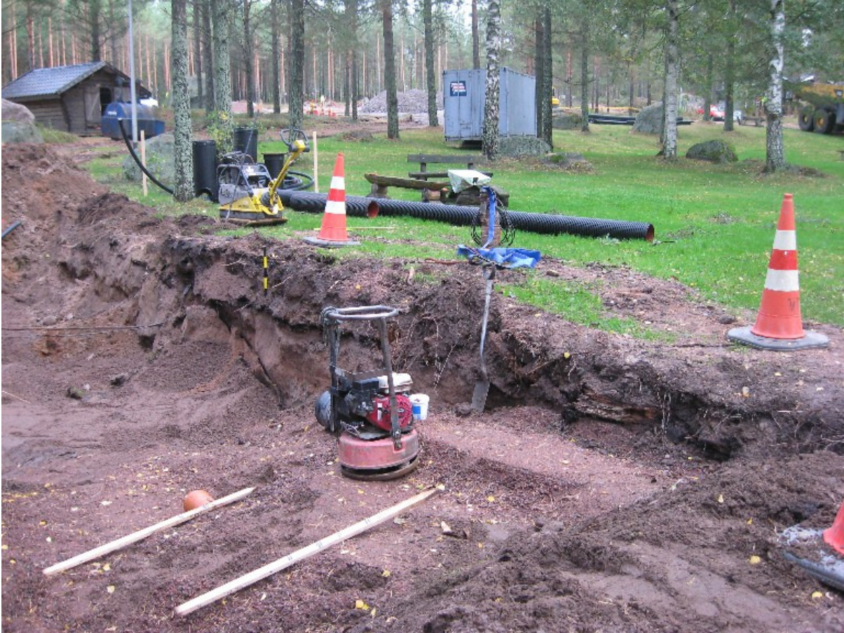
Kuva 21: Putkilinjakaivannon SE-päätä leirintäalueen vanhalla puolella, missä valvontaa ei maankaivutöiden yhteydessä suoritettu. Kaivannon seinämissä esiintyi puunjäännöksiä sekä paikoitellen runsaastikin puuhiiltä, mikä viittaa siihen, että leirintäalueella suoritettujen aiempien laajennustöiden yhteydessä oli alueella tuhoutunut tuntematon määrä inventoimattomia hiilimiiluja. Taustalla leirintäalueen halkovaja. S. Kuva KyM/M. Kykyri.
