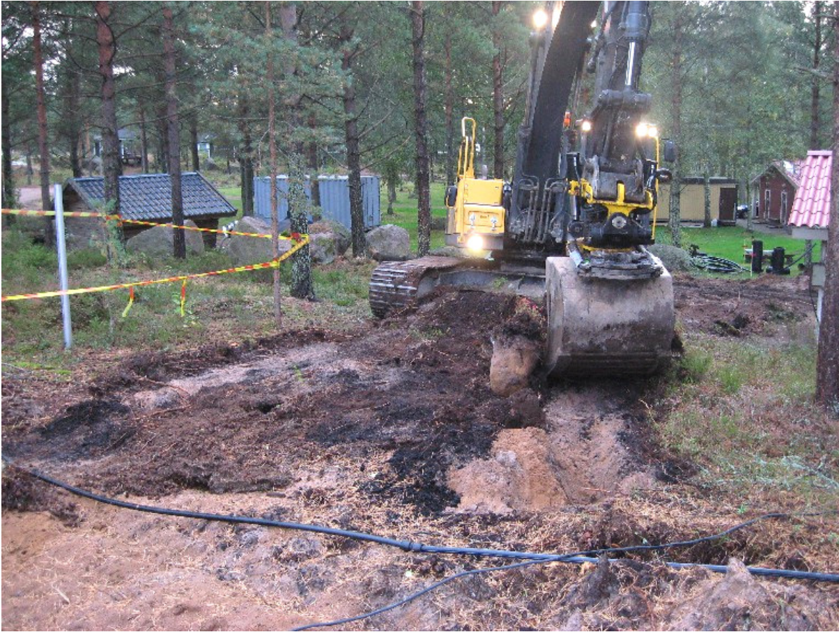
Kuva 19: Pintaturvetta poistetaan miilujen n:o 2 ja 9 väliseltä alueelta. Putkilinjakaivannon NW-pää. W. Kuva KyM/M. Kykyri.
