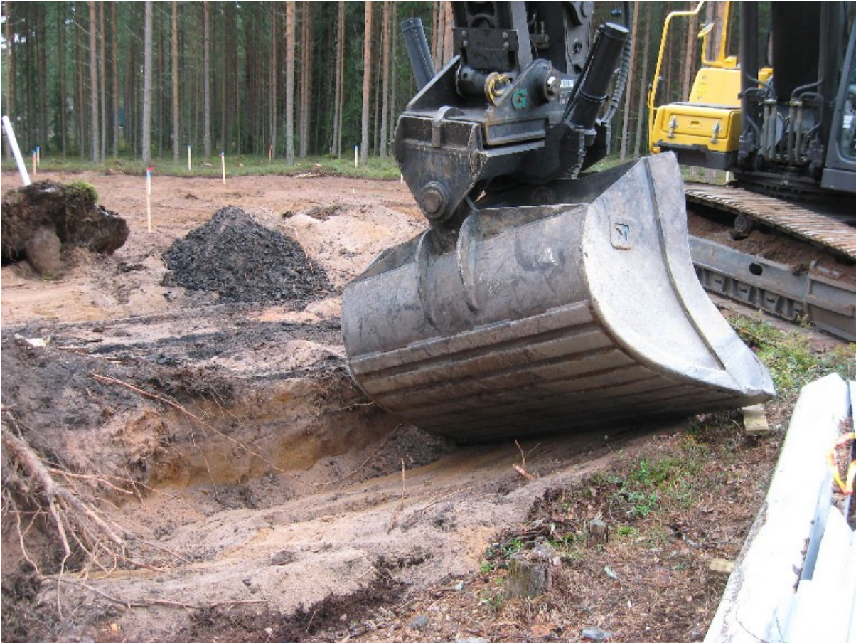
Kuva 7: Miilu n:o 1 itäisivustan leikkausta suoristetaan. NE. Kuva KyM/M. Kykyri.
