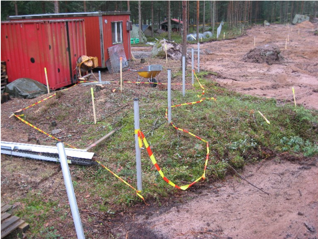
Kuva 8: Miilu n:o 1 ennen kaivutöiden alkamista. Miilun halki kulki aitalinja Santalahden leirintäalueen vanhan ja uuden laajennuspuolen (oikealla) välillä. NE. Kuva KyM/M.Kykyri.
