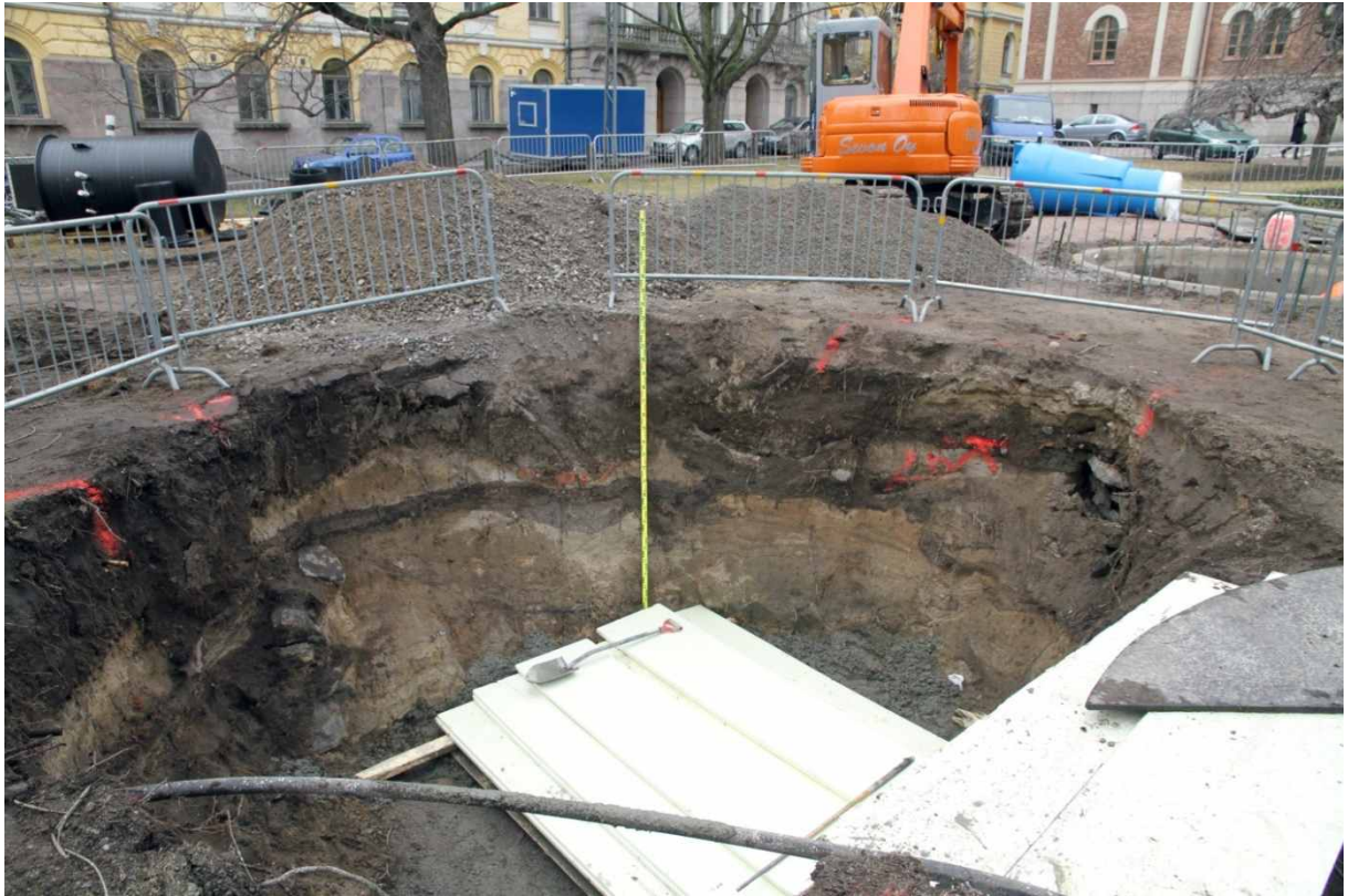
Kuva 23. Kellari ja Suihkualtaan eteläpuoli. Kuopan länsipuolisko. Kuoppa laajimmillaan ennen kaivantojen tekoa pohjoiseen ja länteen (profiili 9). 22.4.2010. Kuvaussuunta: NW.
