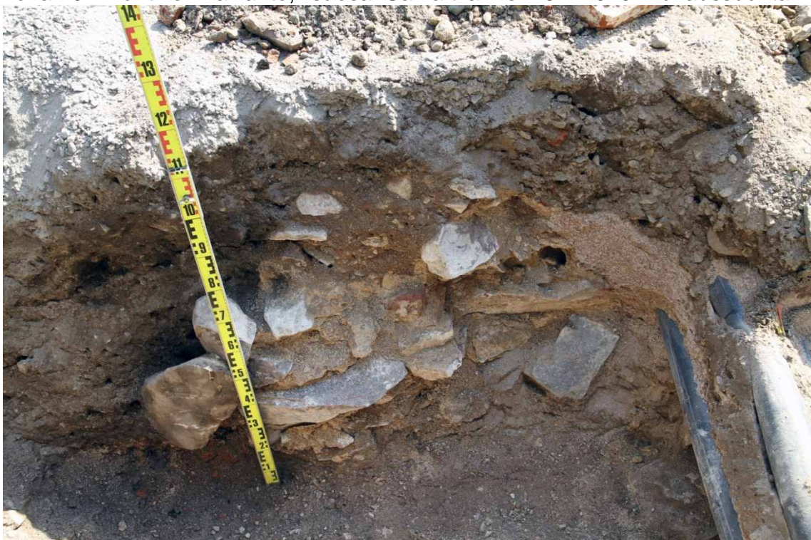
Kuva 105. Läntinen kaivanto, lisäosa. Eteläprofiilissa muoviputkien itäpuolella puustikon puolella näkyy rakennuksen kivijalka aina lähelle maanpintaa. 28.7.2010. Kuvaussuunta: S.
