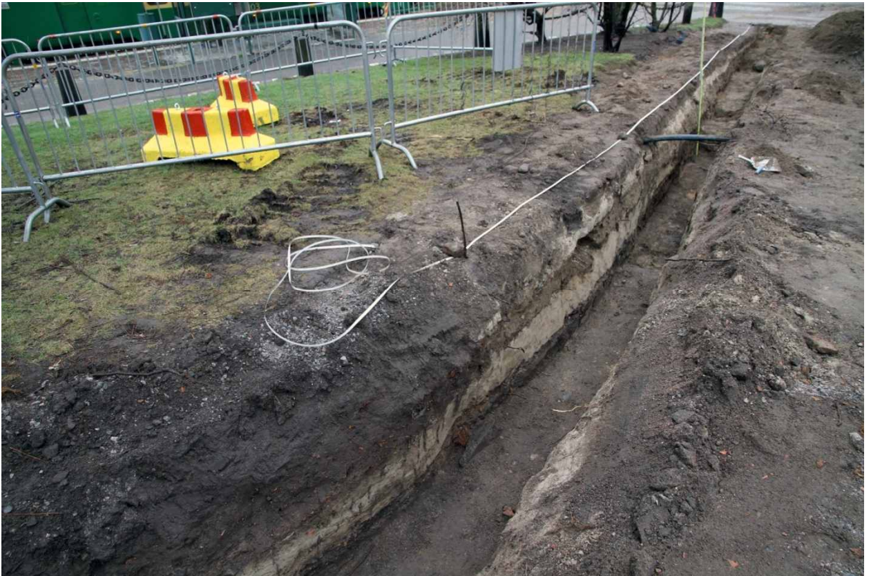
Kuva 63. Läntinen kaivanto. Keskiosa. 29.4.2010. Kuvaussuunta: SW.
