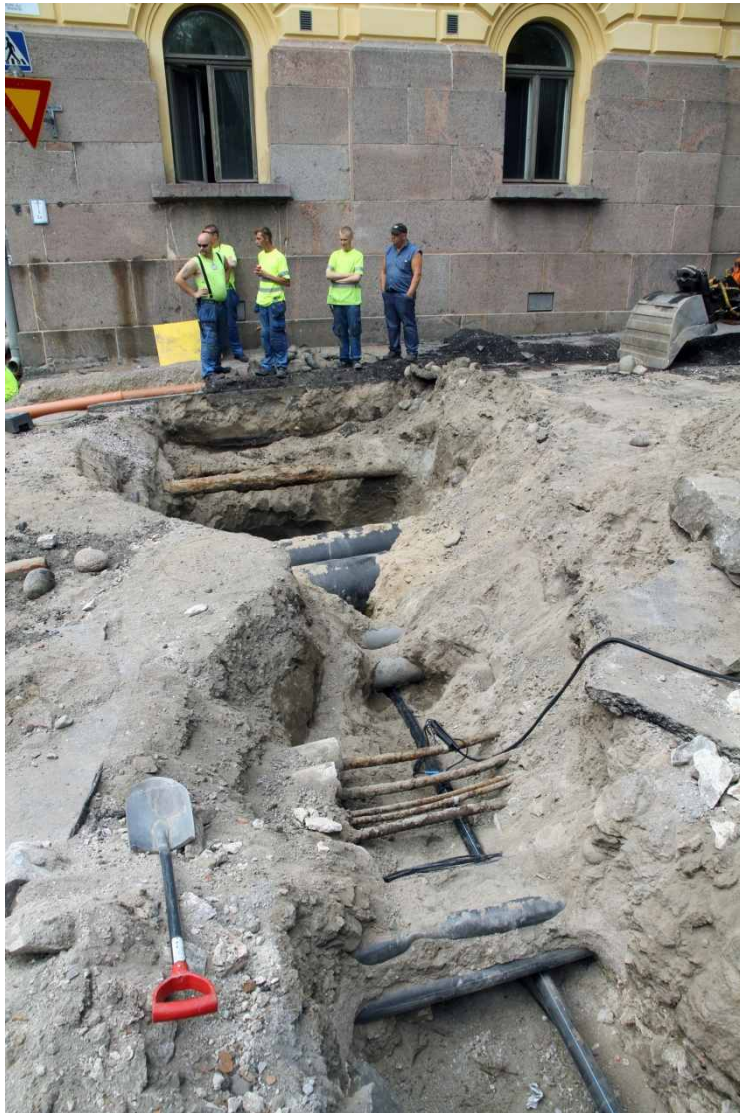
Kuva 108. Läntinen kaivanto, lisäosa. Vesiputkikaivantoa on jatkettu kaukolämpö- ja kaukojäähdytyskaivantojen alitse Ritarikadun länsipuolella sijaitsevan vesiputken luokse. 28.7.2010. Kuvaussuunta: W.
