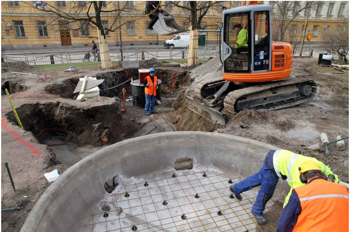
Kuva 35. Suihkualtaan eteläpuoli. Suihkualtaan ja uuden pumppaamon välinen alue on avattu putkien asentamista varten. 27.4.2010. Kuvaussuunta: S.
