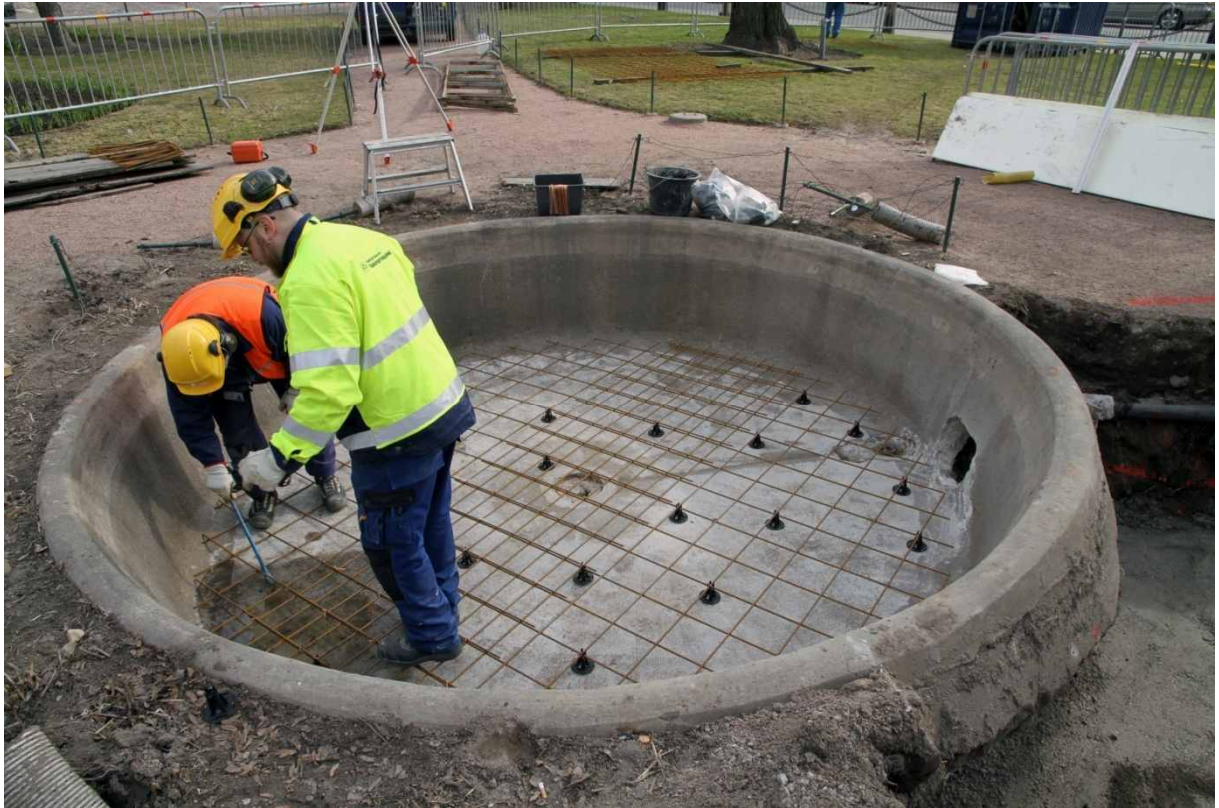
Kuva 41. Suihkualtaan eteläpuoli. Altaan uutta pohjaa raudoitetaan. 27.4.2010. Kuvaussuunta: NE.
