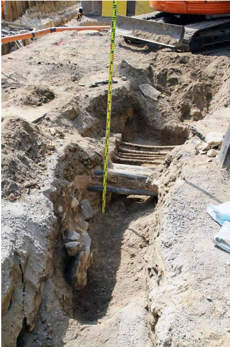
Kuva 102. Läntinen kaivanto, lisäosa. Muoviputkien ja kaapeleiden alitus on valmistunut. 28.7.2010. Kuvaussuunta: W.
