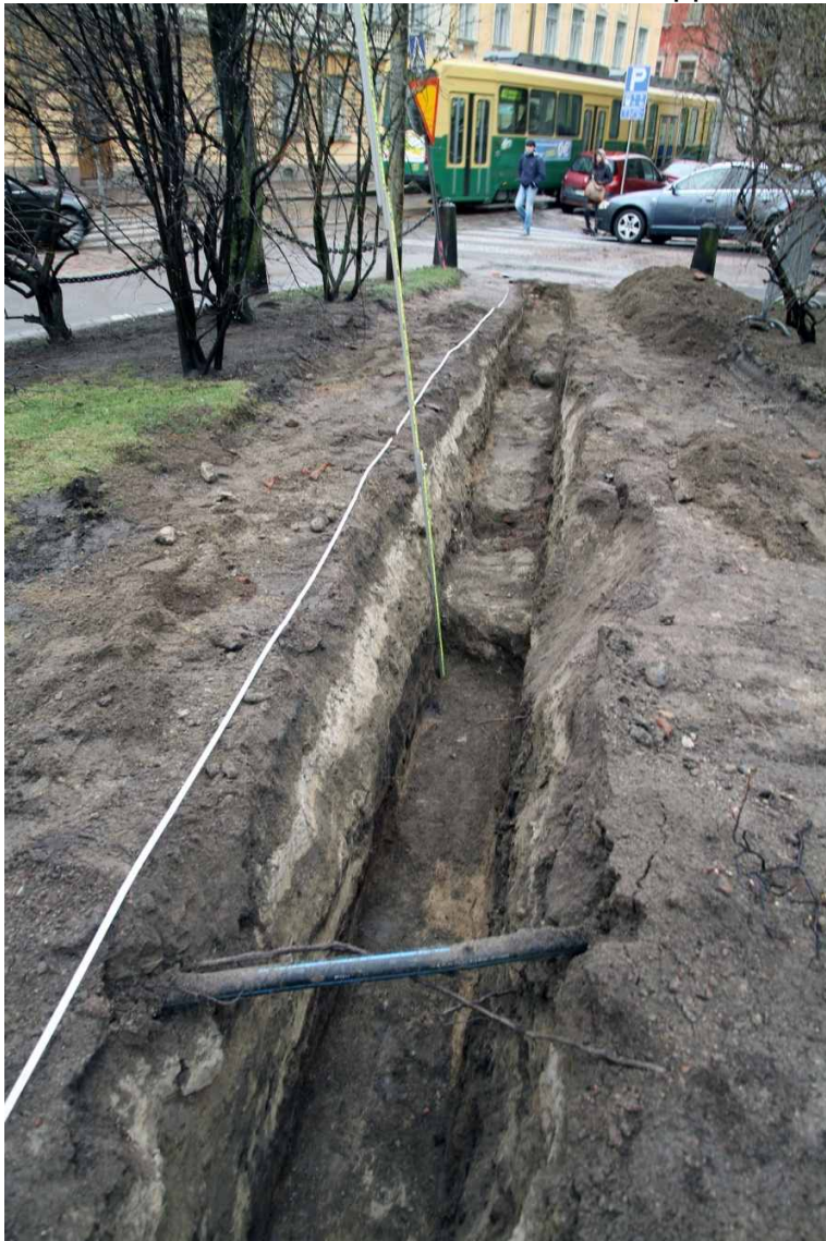
Kuva 58. Läntinen kaivanto. Keski- ja länsiosat. Jälkimmäisestä latan takaa on poistettu vain pintakerrokset. 29.4.2010. Kuvaussuunta: SW.
