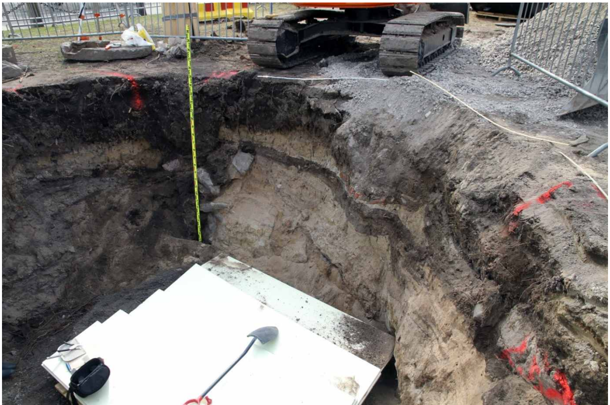
Kuva 24. Kellari ja Suihkualtaan eteläpuoli. Kuopan länsipuolisko. Sama tilanne. 21.4.2010. Kuvaussuunta: SW.
