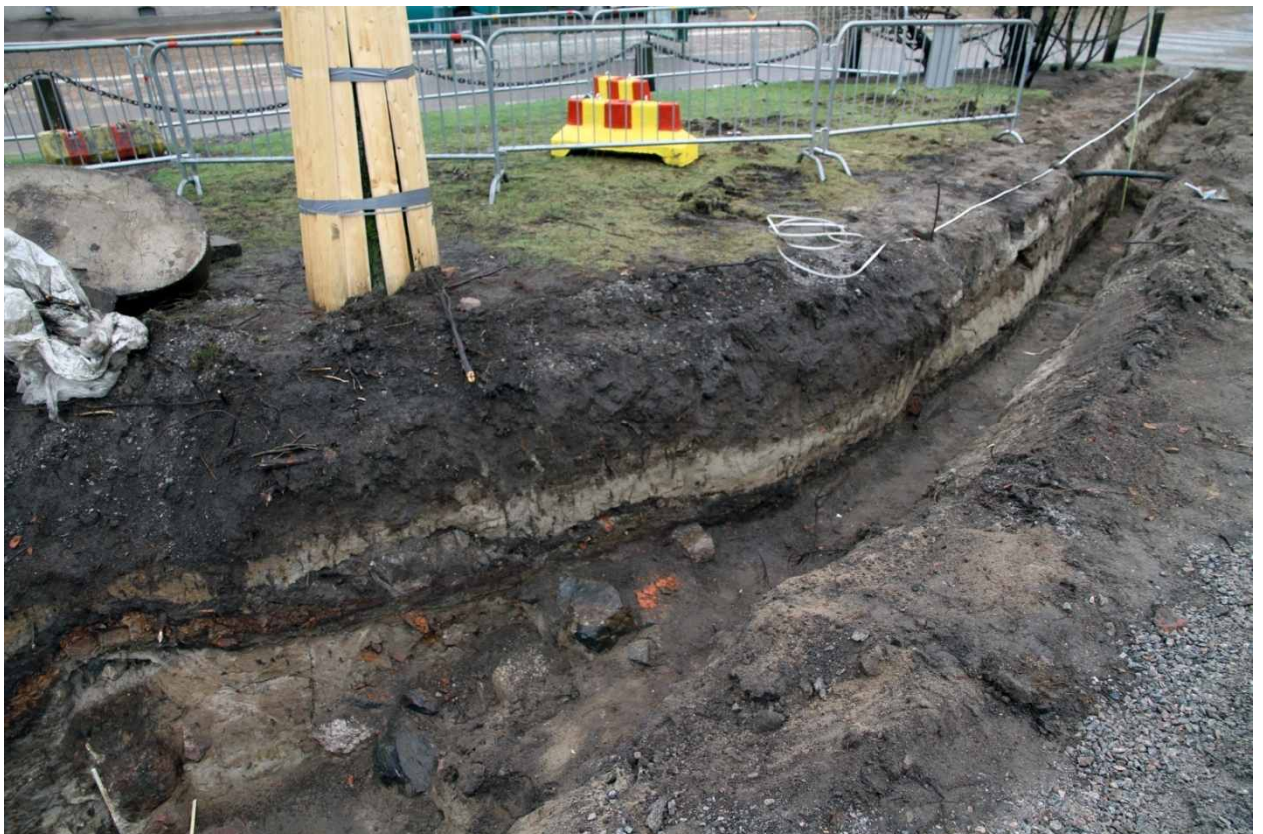
Kuva 62. Läntinen kaivanto. Itäosa. 29.4.2010. Kuvaussuunta: SW.
