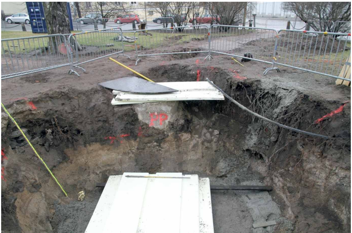
Kuva 34. Suihkualtaan eteläpuoli. Kuopan itäpuolisko. Profiileissa on näkyvissä enimmäkseen pintamultakerros ja uusia täyttökerroksia ennen puhdasta hiekkaa. Latan kohdalla on edellisen kuvan louhintakivet. Oikealla on alempana kellarin vanhoja täyttömaita. 22.4.2010. Kuvaussuunta: E.
