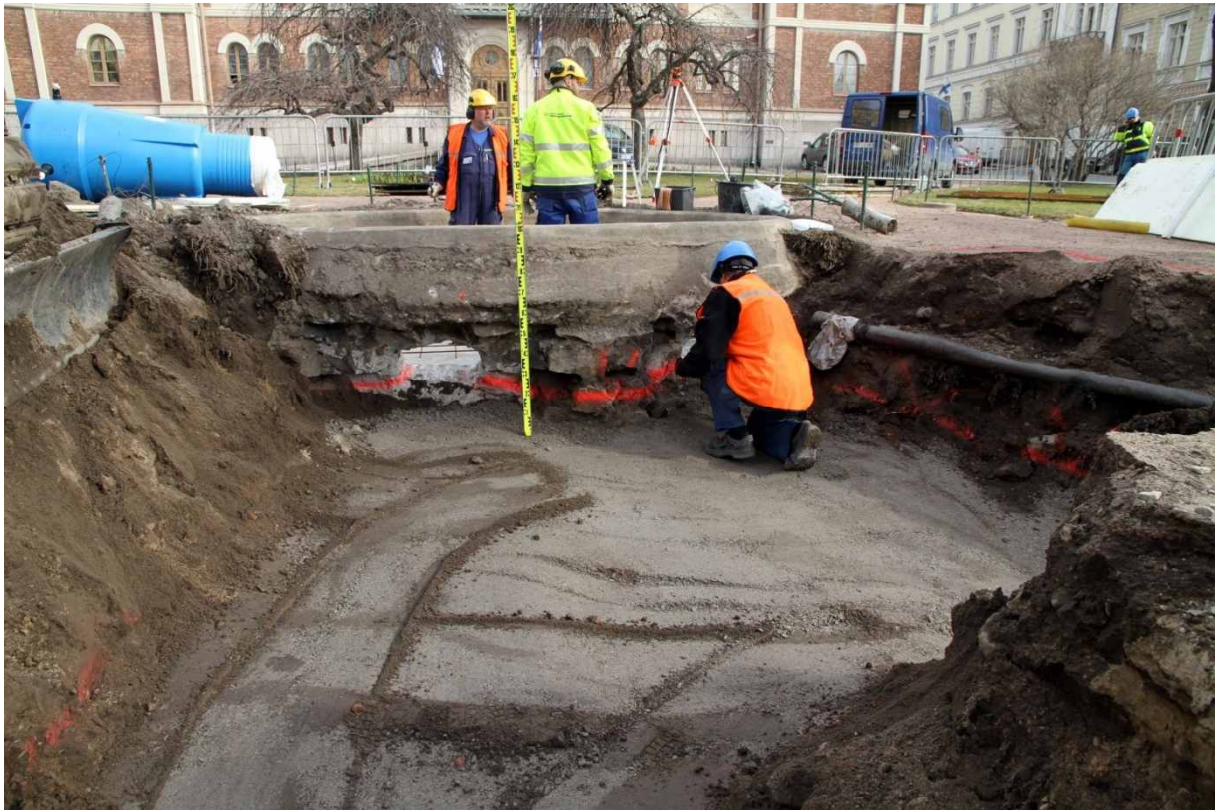
Kuva 39. Suihkualtaan eteläpuoli. Putkia varten on puhkottu altaan seinään uusia reikiä. 27.4.2010. Kuvaussuunta: N.
