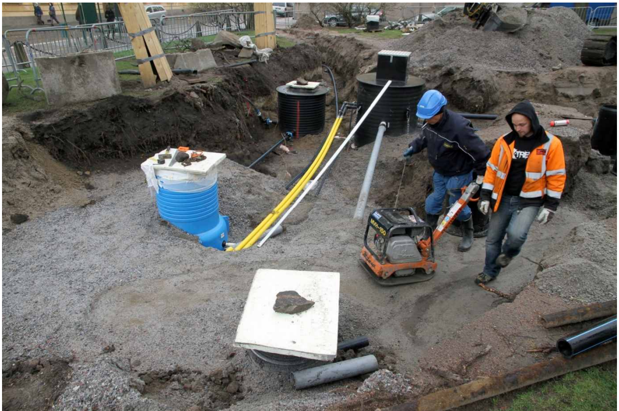
Kuva 99. Suihkualtaan eteläpuoli ja Kellari. Sepelikerrosta tiivistetään. 10.5.2010. Kuvaussuunta: W.
