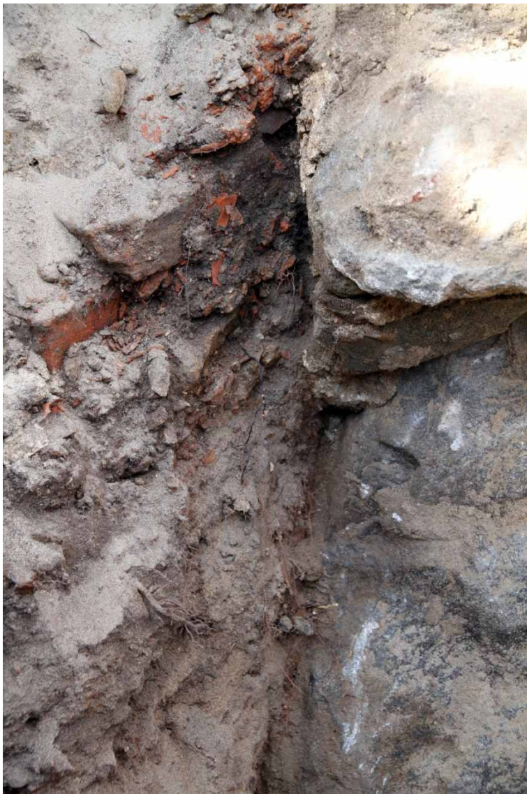
Kuva 18. Kellari. Kuopan lounaisosa. Kellarin sisäpuolen laastikerrosta ja vanhoja täyttömaita. 19.4.2010. Kuvaussuunta: W.
