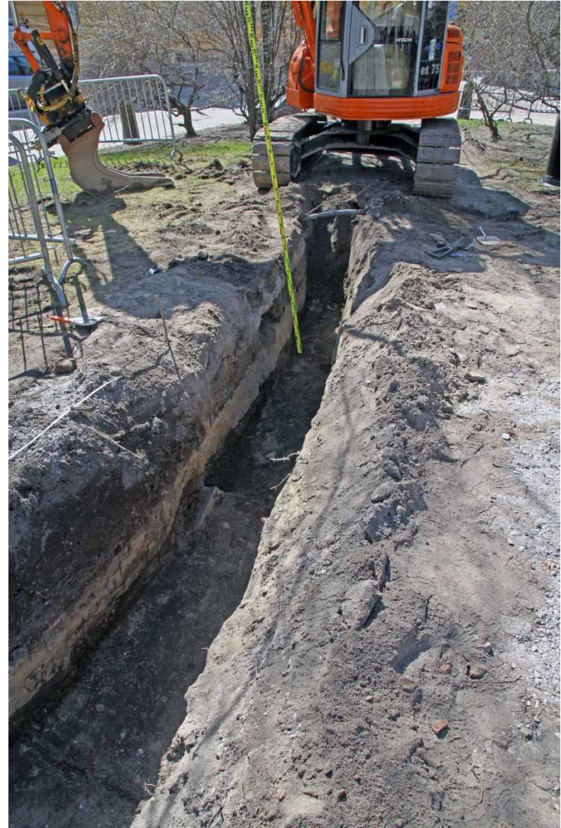
Kuva 54. Läntinen kaivanto. Itäosa. Yleiskuva. 28.4.2010. Kuvaussuunta: SW.
