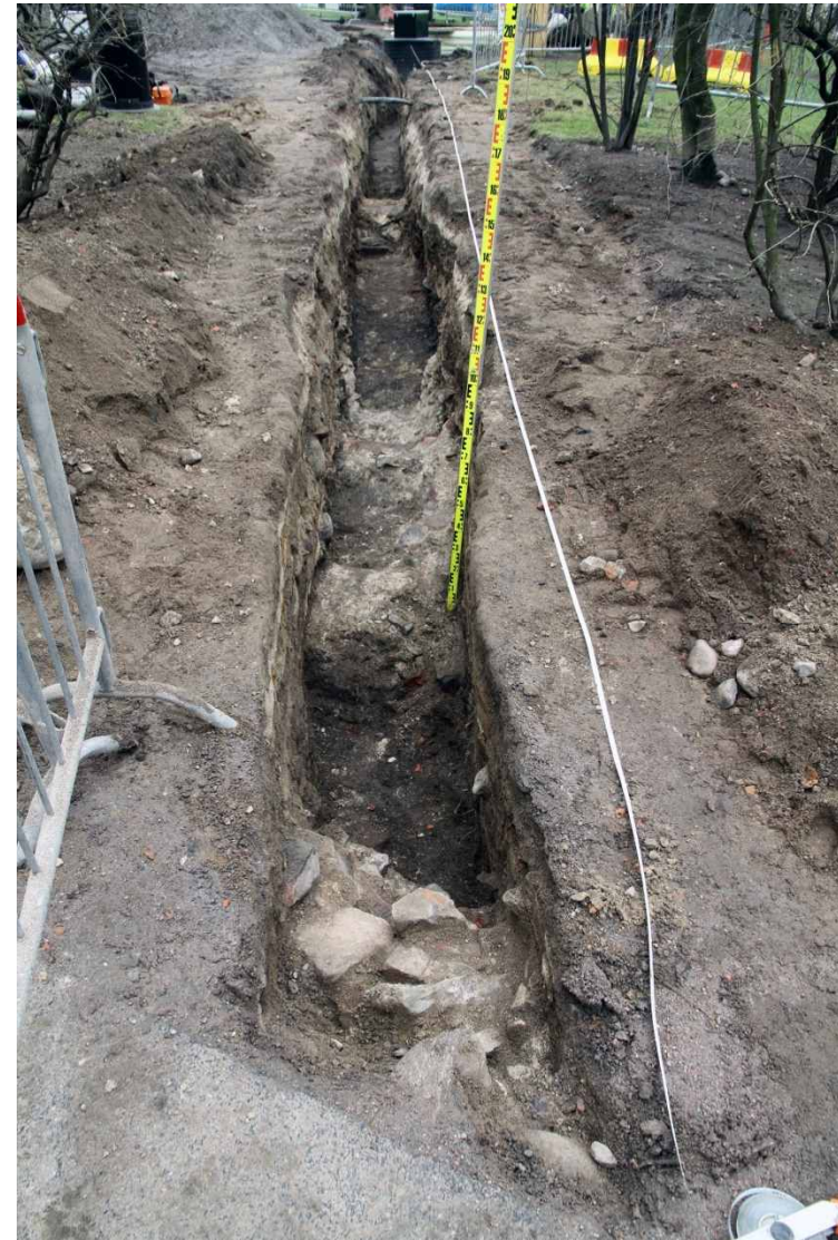
Kuva 80. Läntinen kaivanto. Länsiosa. Sama tilanne. 30.4.2010. Kuvaussuunta: SW.
