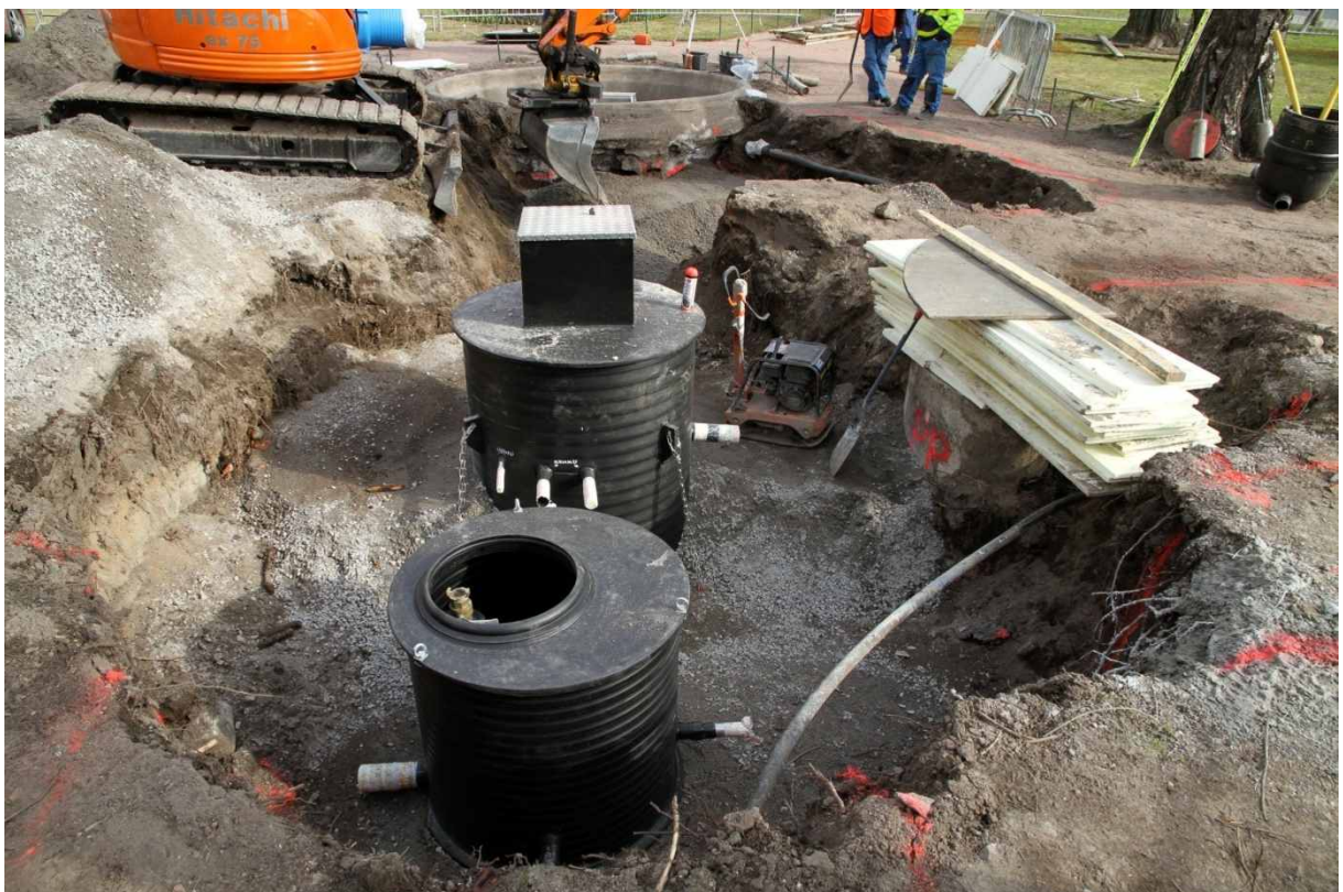
Kuva 40. Kellari ja Suihkualtaan eteläpuoli. Edessä on vesiposti ja keskellä pumppaamo. Pinon alla on vanha kaivo. Kellarin pohjoisseinä sijaitsee ja sijaitsee lähimmän kaivon linjalla. 27.4.2010. Kuvaussuunta: N.
