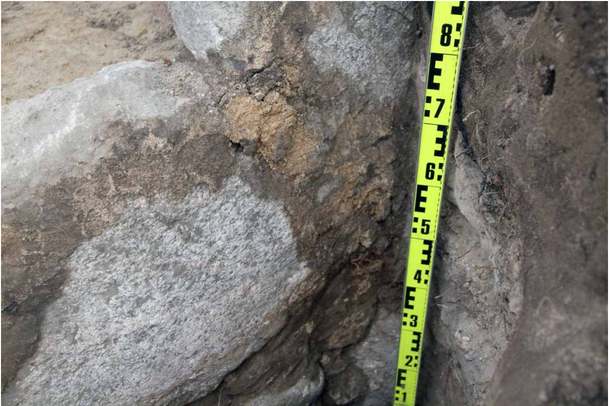
Kuva 89. Kellari. Kellarin itäinen osa. Itäseinän laastikerrosta eteläosassa. 3.5.2010. Kuvaussuunta: SE.
