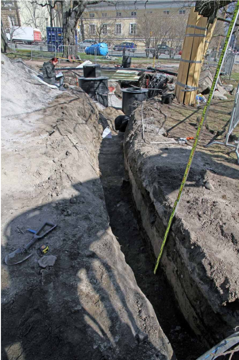
Kuva 53. Läntinen kaivanto. Itäosa. Yleiskuva. 28.4.2010. Kuvaussuunta: NE.
