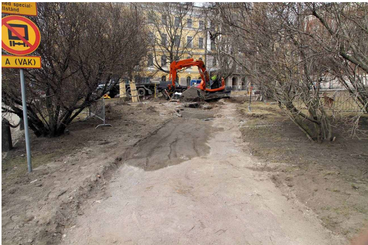
Kuva 1. Itäinen kaivanto. Puistokäytävän eteläreunassa sijainnut kaivanto on jo enimmäkseen peitetty kuvaushetkellä. 15.4.2010. Kuvaussuunta: NW.
