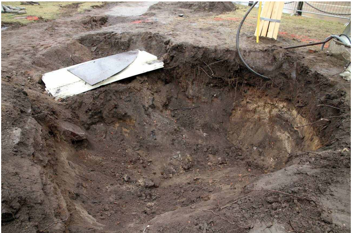
Kuva 4. Suihkualtaan eteläpuoli. Edellisen kuvan kaivon (levyjen alla) länsipuolelle on alettu kaivaa kuoppaa uudelle pumppaamolle. 16.4.2010. Kuvaussuunta: SE.
