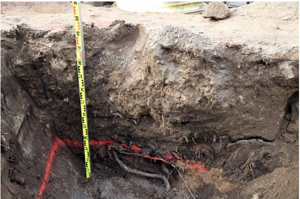
Kuva 38. Suihkualtaan eteläpuoli. Lähikuva profiilista edellisen kohdan eteläpuolelta. 27.4.2010. Kuvaussuunta: S.
