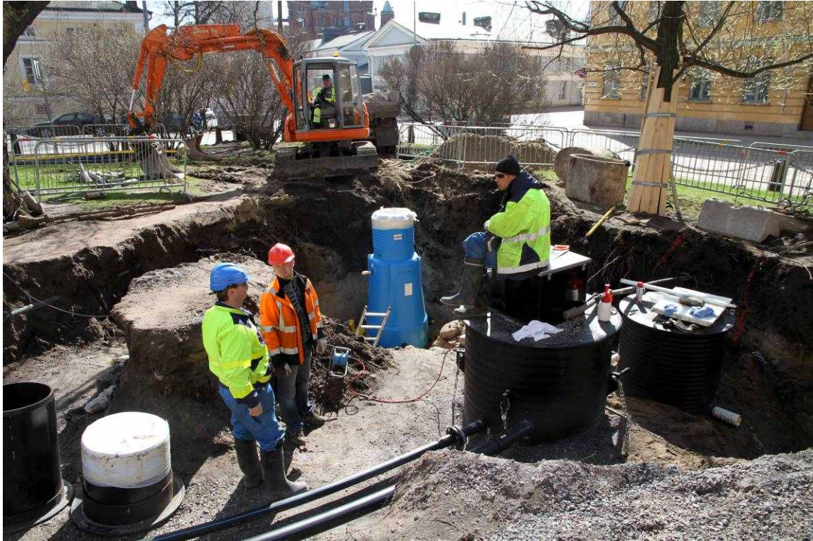
Suihkualtaan pumppaamon ja kaivojen peruskunnostamisen työmaa-alue tekijöineen
