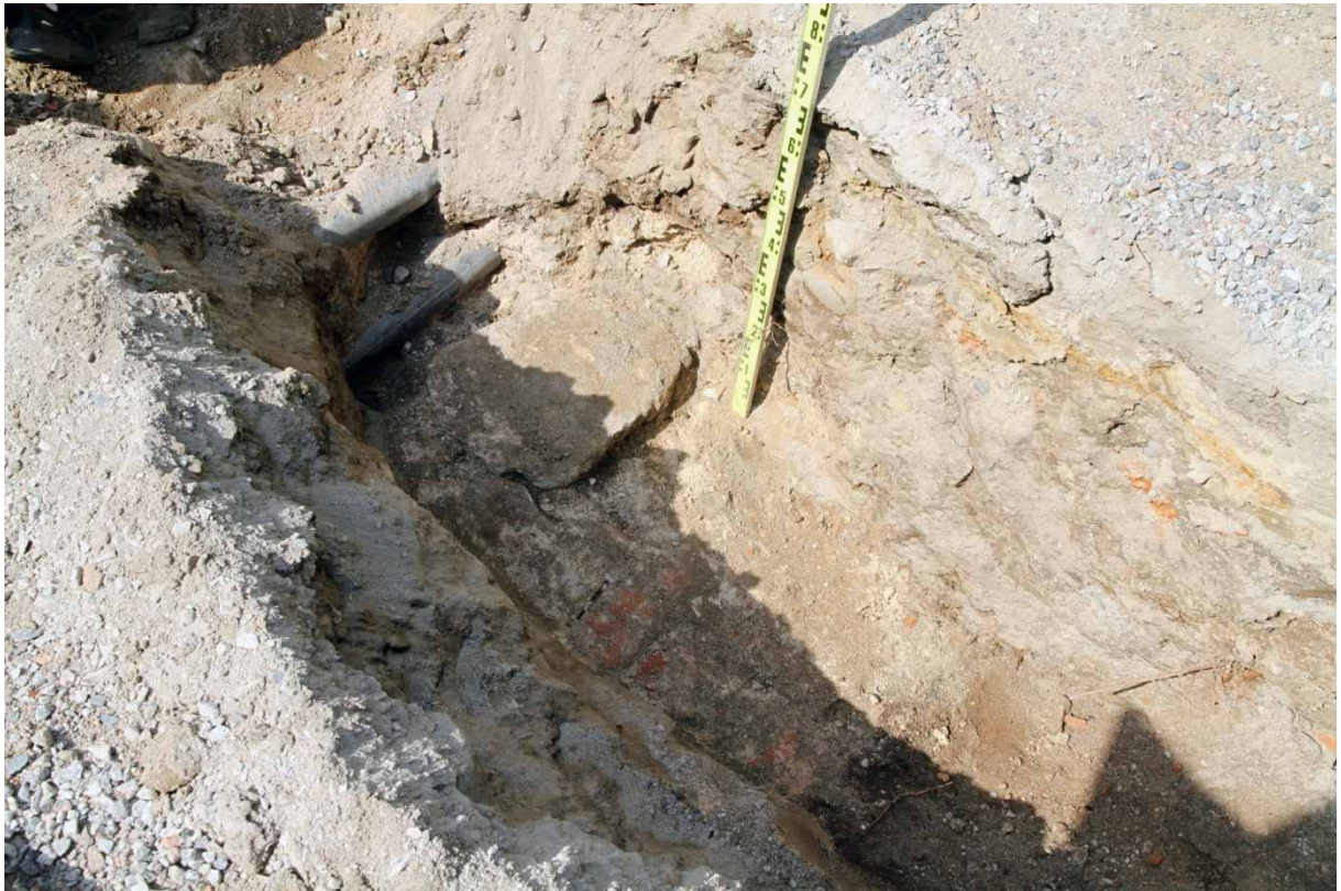
Kuva 100. Läntinen kaivanto, lisäosa. Rakennuksen läntinen kivijalka. Jalkakäytävän kohdalla sijaitsevien muovisten suoja-putkien etupuolelta on puistikon puolelta poistettu jo aiemmin keväällä esille otetun kivijalan laasti-, tiili- ja kivirakennetta. 28.7.2010. Kuvaussuunta: NW.
