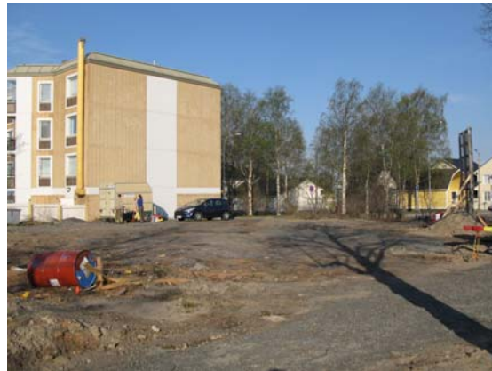
Kuva 12. Digitaalinen kuva 21792: 7. Yleiskuva tontin länsi- ja pohjoispuolesta. Kuvattu lounaaseen.
