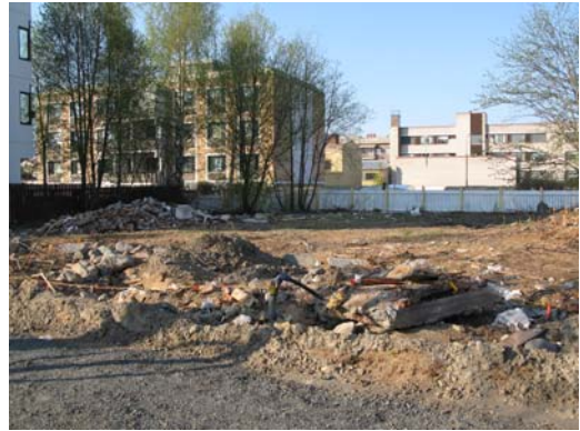
Digitaalikuva 217921:6. Yleiskuva tontista II/9/24, eteläosa. Kuvattu etelään.
