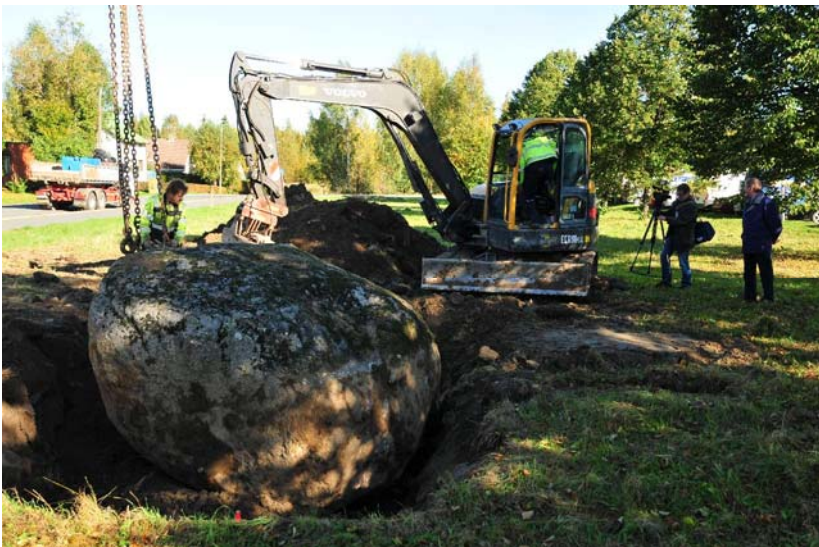
Kivi paikallaan sitä varten kaivetussa kuopassa. Kuvattu lounaasta. (DG2092:20)
