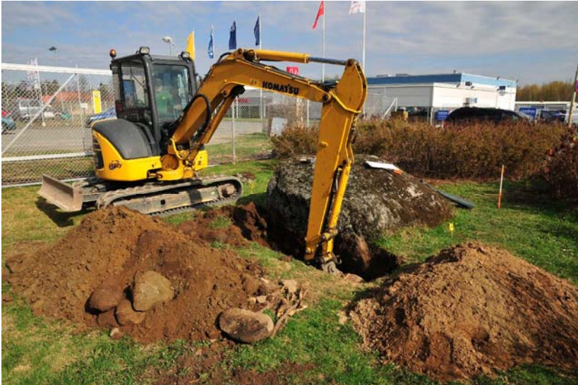
Koekuopituksen ja näytteiden oton jälkeen kiven ympäristöä tutkittiin kaivurin avulla. Kuvattu kaakosta. (DG2092:7)
