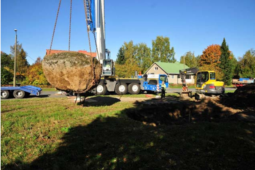
Kiveä nostetaan uuteen paikkaan. Kuvattu etelästä. (DG2092:18)
