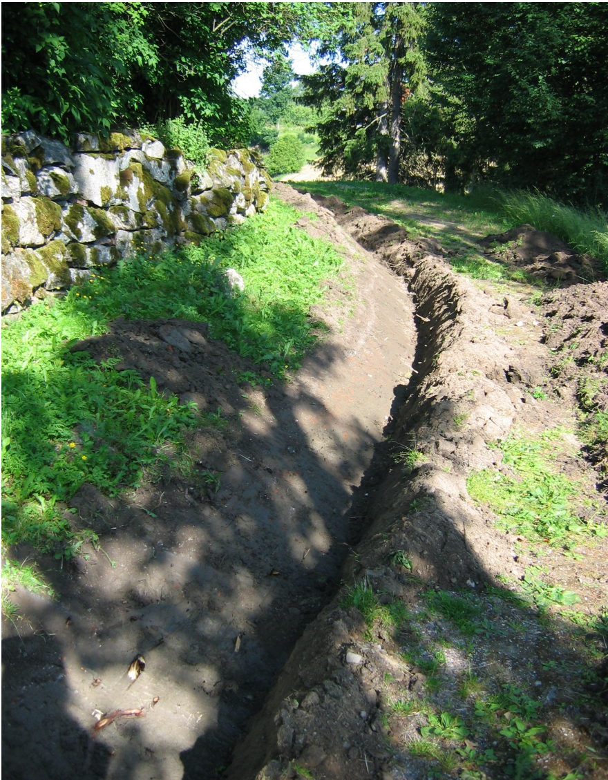
DK 8_2010 Koeojan 16 koillispäätä kaivettuna. Kuva koillisesta.
