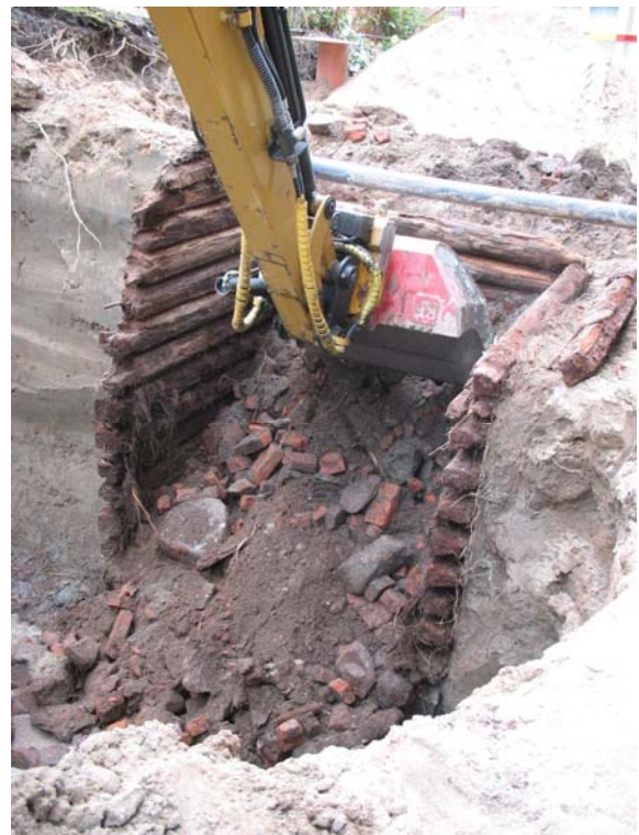
Digikuva 217919:45. Kaivon sisustaa tyhjenetään koneellisesti. Kuvattu länteen.
