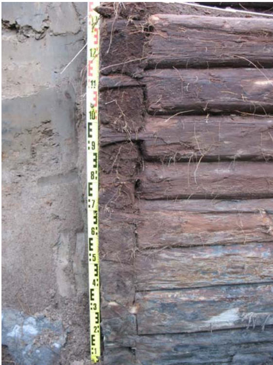
Digikuva 217919:37. Kaivon etelänurkan salvokset . Kuvattu luoteeseen.
