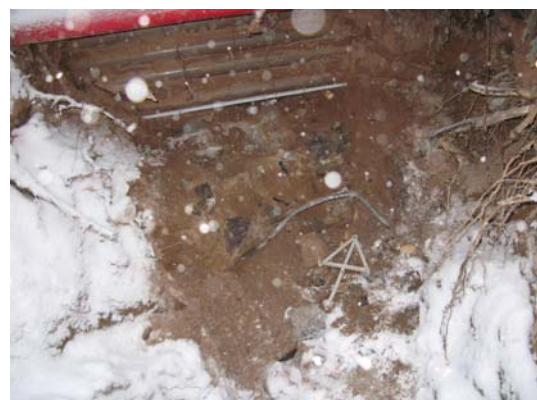
Kuva 21. Digitaalinen kuva 217919: 67. Kivijalan katkelmaan, joka sijaitsi kaapeloinnin alla, liittyi raudoituksia. Kuvattu pohjoiseen.
