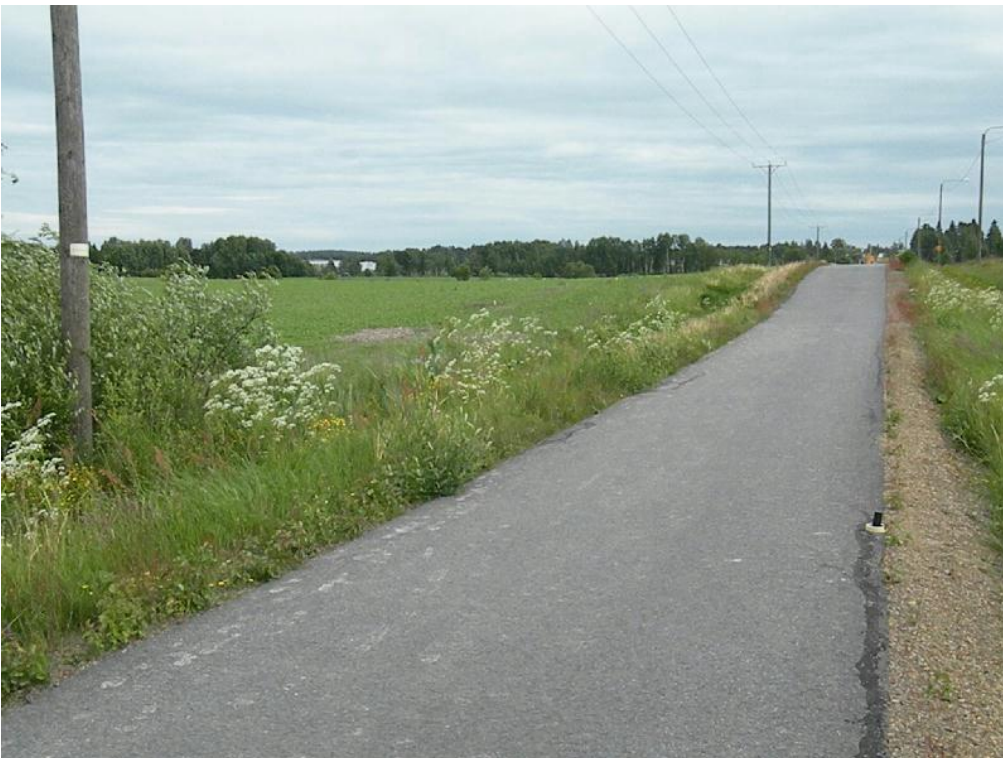
Kuva 4. Kiintopiste (90,92 m mpy) kevyenliikenteenväylällä kulmaprisman ja teippirullan kohdalla. Kuvattu lounaasta. (kuva 0039)
