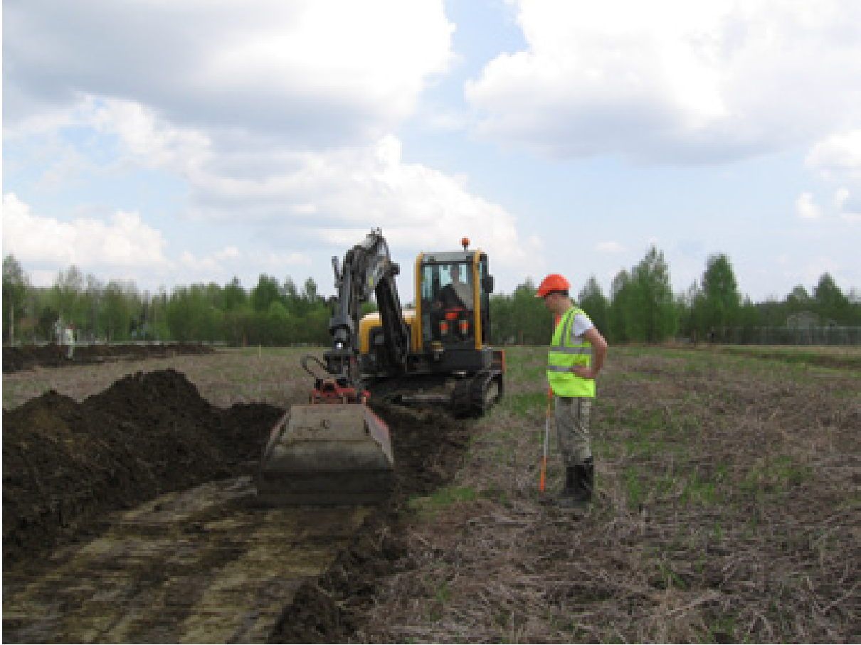
DG1458:10 Koekaivausta, kaivinkone poistaa peltokerrosta, arkeologi valvoo. Kuva P. Kankkunen.
