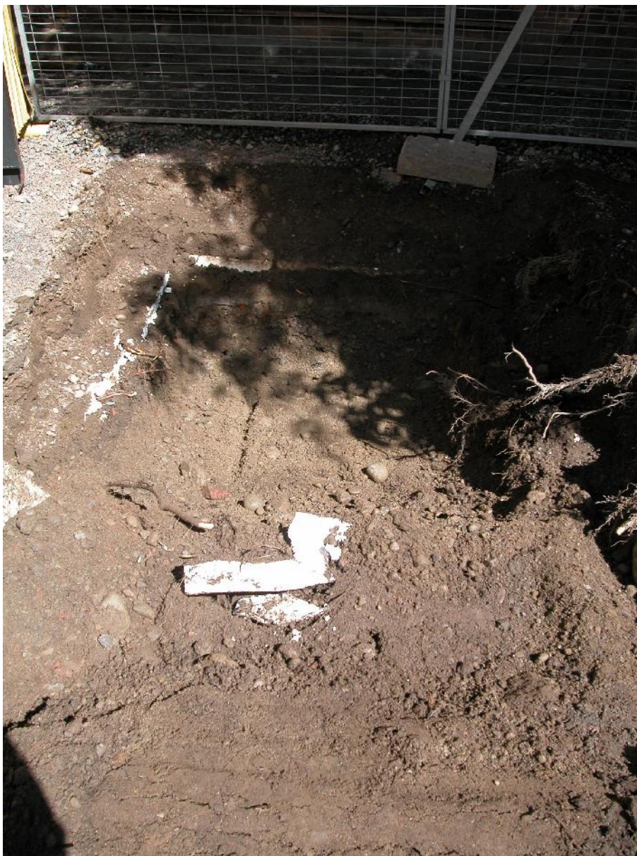
Kuva 13. Alue I. Kaivetusta kuopasta paljastui yhtenäistä kiveystä. Kuvattu lännestä. 18.6.2010.
