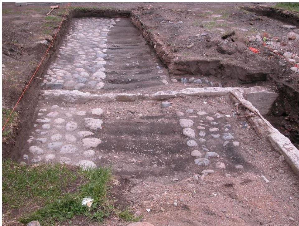
Kuva 19. Nuoremman betonisokkelin rakentaminen oli paikoittain rikkonut vanhemman teollisuuspihan rakenteita. Kuvassa näkyy kiveystä, radanpohjaa ja betonisokkeliä. Betonisokkelissa näkyy raudoitukseen käytettyä romurautaa, muun muassa paikalla aiemmin sijainneen rautatien kiskoja. Kuvan oikeassa laidassa erottuu syvemmälle kaivettu osa koeajaa, josta profiili dokumentoitiin. Kuva: Kalle Luoto 14.6.2010.
