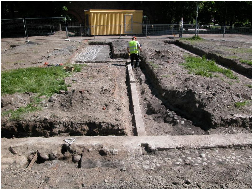
Kuva 18. Betonisokkeli tuli esiin heti pintamaan alapuolelta. Vasemmassa alakulmassa kiskojen jäännöksiä. Kuva: Kalle Luoto 8.6.2010.
