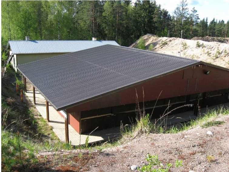
Kuva. Nykyisin redutin paikalla on ampumaradan rakennuksia. Päivi Hakanpää RHOA 125863:28.
