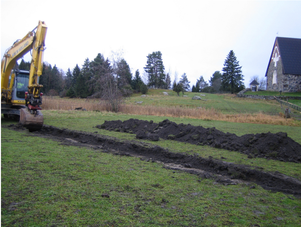
Linjan 1 pintamaan kuorinnan aloitus 26.10. kirkon eteläpuolisella laidunalueella. Pohjoisesta. 26.10. TJ. (DK 1/KY)
